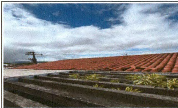
EMASSAMENTO DAS PAREDES
