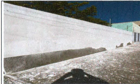
EMASSAMENTO DAS PAREDES
