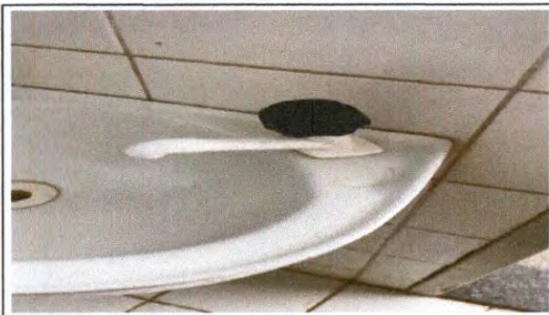
EMASSAMENTO DAS PAREDES
