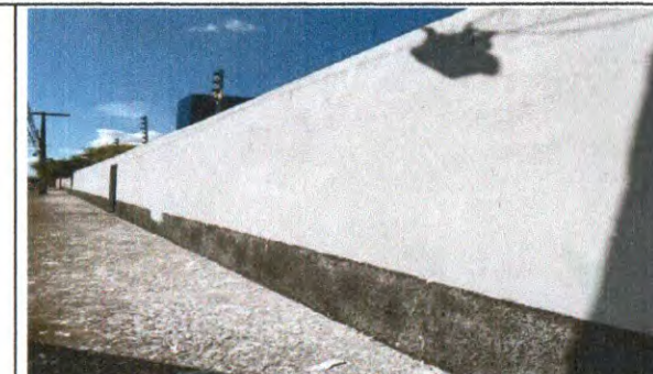
EMASSAMENTO DAS PAREDES
