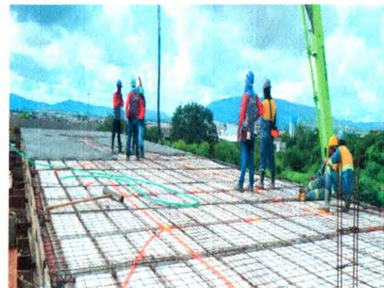
INSTALAÇÃO ELÉTRICA; AÇO E CONCRETO DAS LAJES
