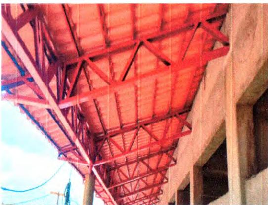
COBERTURA - ESTRUTURA METÁLICA; TELHAMENTO CERÂMICO
