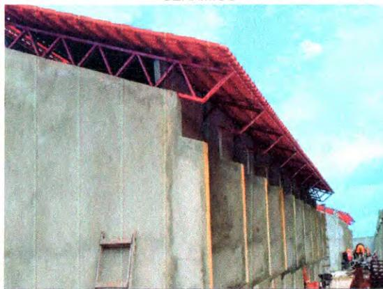
COBERTURA - ESTRUTURA METÁLICA; TELHAMENTO CERÂMICO
