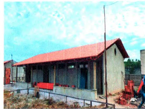
COBERTURA - ESTRUTURA METÁLICA; TELHAMENTO CERÂMICO; BANCOS DE CONCRETO
