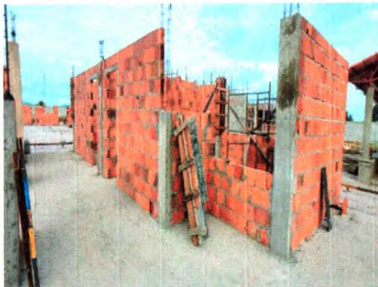
ALVENARIA DE VEDAÇÃO, FORMA, AÇO E CONCRETO DOS PILARES
