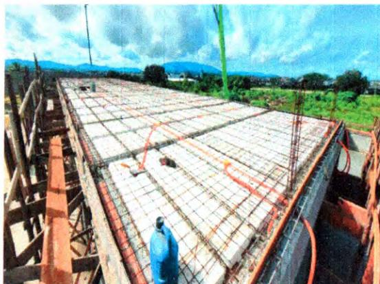
AÇO DAS LAJES; INSTALAÇÃO ELÉTRICA
