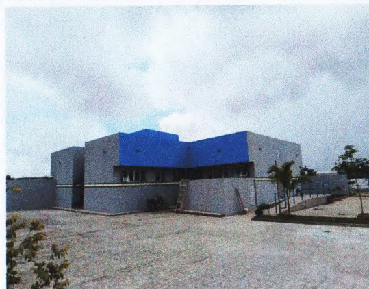
LIMPEZA E ESQUADRIAS
