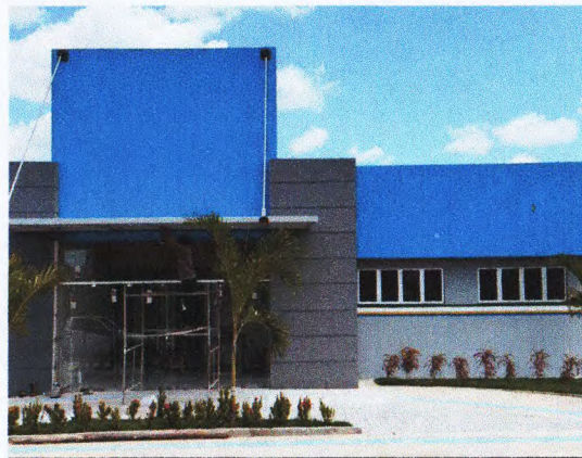
COBERTURA METÁLICA E ESQUADRIAS
