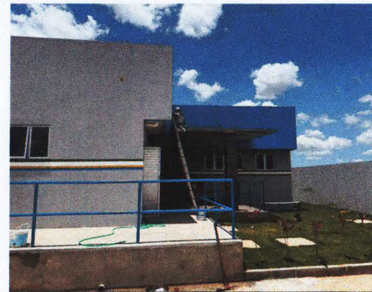
COBERTURA METÁLICA, PINTURA METÁLICA E ESQUADRIAS
