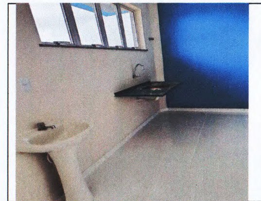
TORNEIRAS E ESQUADRIAS
