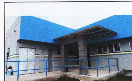
COBERTURA METÁLICA, INSTALAÇÃO ELÉTRICA E ESQUADRIAS
