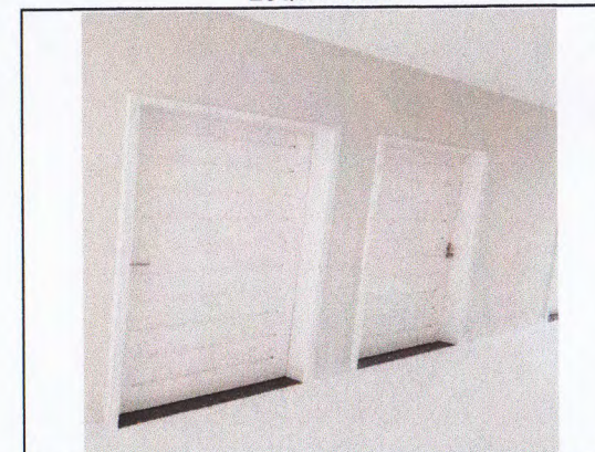
PINTURA DE ESQUADRIAS E LIMPEZA
