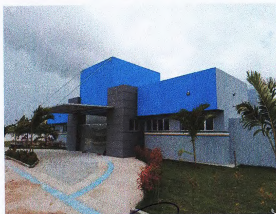
PINTURA DE ESQUADRIAS E LIMPEZA
