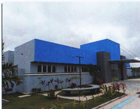
COBERTURA METÁLICA, INSTALAÇÃO ELÉTRICA E ESQUADRIAS
