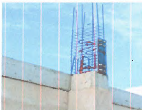
ESTRUTURA METÁLICA: PLACA DE ANCORAMENTO DAS TESOURAS
