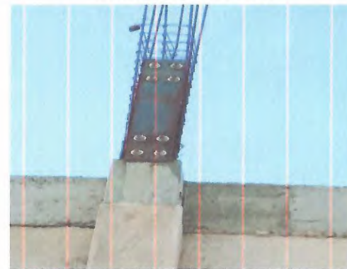
ESTRUTURA METÁLICA: PLACA DE ANCORAMENTO DAS TESOURAS
