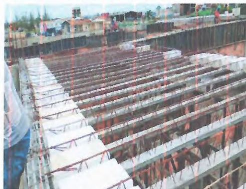
FORMA DE VIGAS E VIGOTAS - LAJE 10,35
