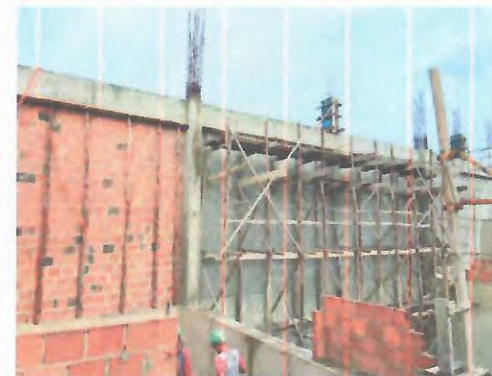
ALVENARIA DE VEDAÇÃO, CONCRETO, FORMA E AÇO DOS PILARES E CHAPISCO
