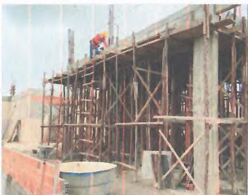
ESCORAMENTO - LAJE 10,35 E LAJE NÍVEL 1
