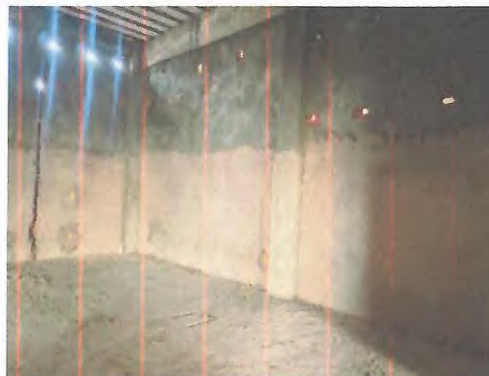
INSTALAÇÃO ELÉTRICA, CHAPISCO DE PAREDE
