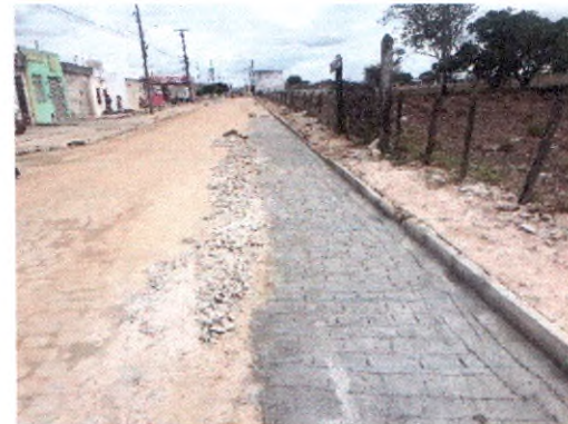
AVENIDA PADRE AIRTON GONÇALVES
