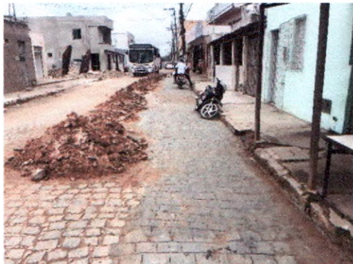
AVENIDA PADRE AIRTON GONÇALVES
