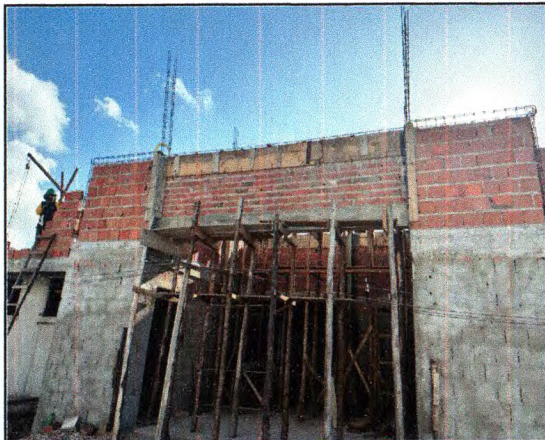
ESCORAMENTO DA LAJE MACIÇA
