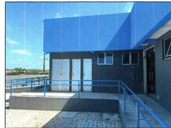
PINTURA DO CORRIMÃO, PAVIMENTAÇÃO EM PARALELEPÍPEDO E ESQUADRIAS DE ALUMÍNIO
