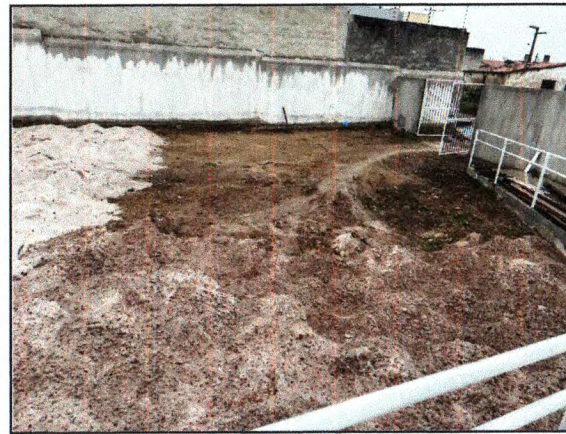
CORRIMÃO E COLCHÃO DE AREIA
