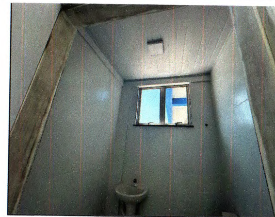
REVESTIMENTO CERÂMICO E LUMINÁRIAS
