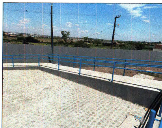
PINTURA DO CORRIMÃO E PAVIMENTAÇÃO EM PARALELEPÍPEDO
