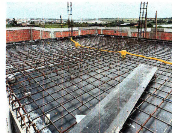
ARMAÇÃO LAJE MACIÇA
