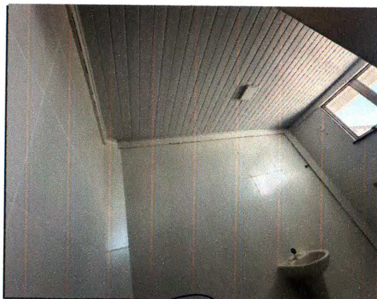
REVESTIMENTO CERÂMICO E LUMINÁRIA
