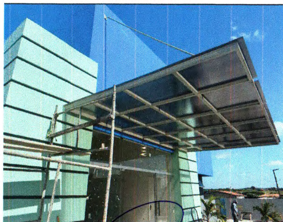
COBERTURA METÁLICA E POLICARBONATO
