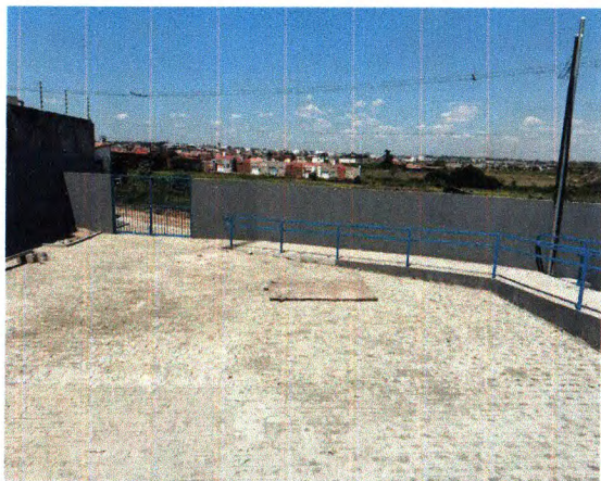
PINTURA DO CORRIMÃO E PAVIMENTAÇÃO EM PARALELEPÍPEDO
