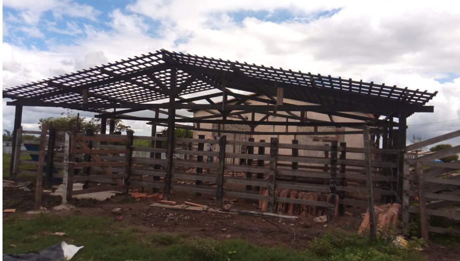
Fotos 11. Destelhamento e substituição de madeiramento no Curral, associado ao Bloco do Abrigo
