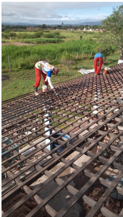
Fotos 07. Aplicação de imunizante em toda a cobertura do Bloco do Abrigo
