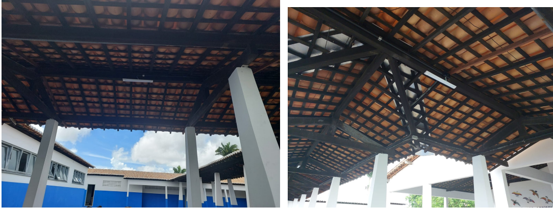
Fotos 09. Instalação de pontos de luz e luminárias em todos os corredores da Escola
