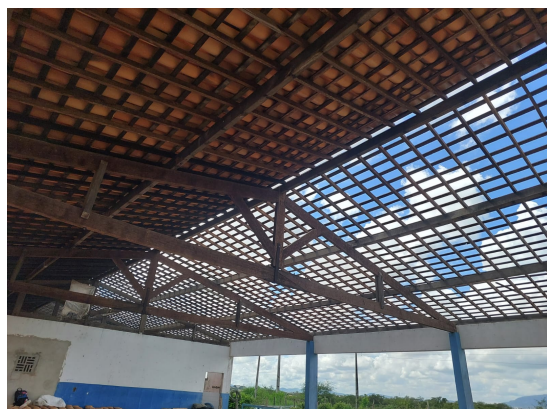
Fotos 08. Retelhamento de todo o Bloco do Abrigo
