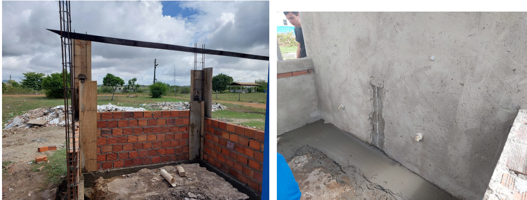
Fotos 03. Execução de alvenaria em bloco cerâmico com chapisco e reboco na construção da Lavanderia. Instalação de pontos de água e esgoto
