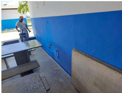
Fotos 01. Pintura de parede do bloco Sala de Aula onde foi adicionado um ponto de água para instalação de filtro
