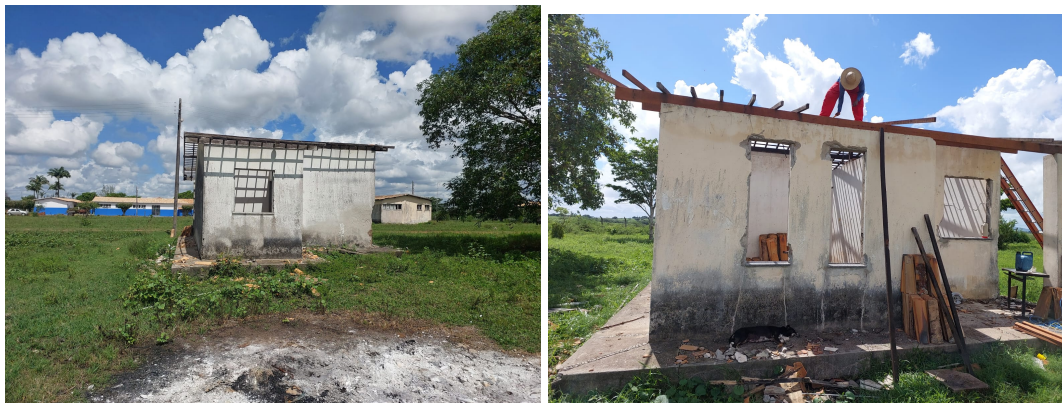
Fotos 06. Remoção de telhas para lavagem na Casa do Vigia 02 e substituição de peças de madeira danificadas. Instalação de novos peitoris nas janelas.
