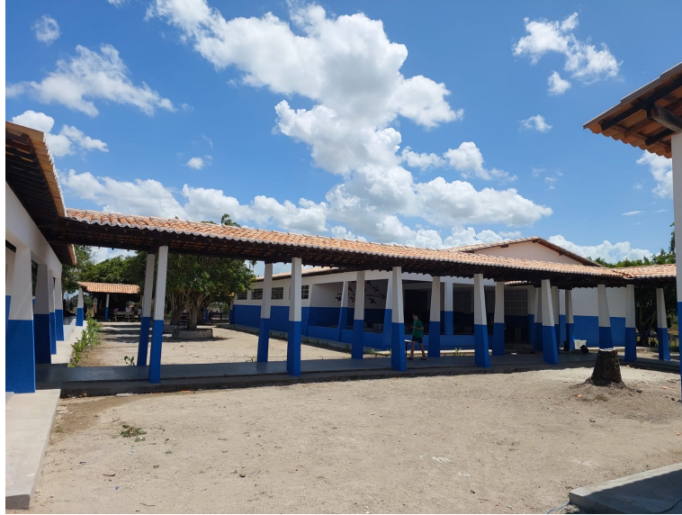
Fotos 05. Emassamento do beiral e cumieira de toda a circulação
