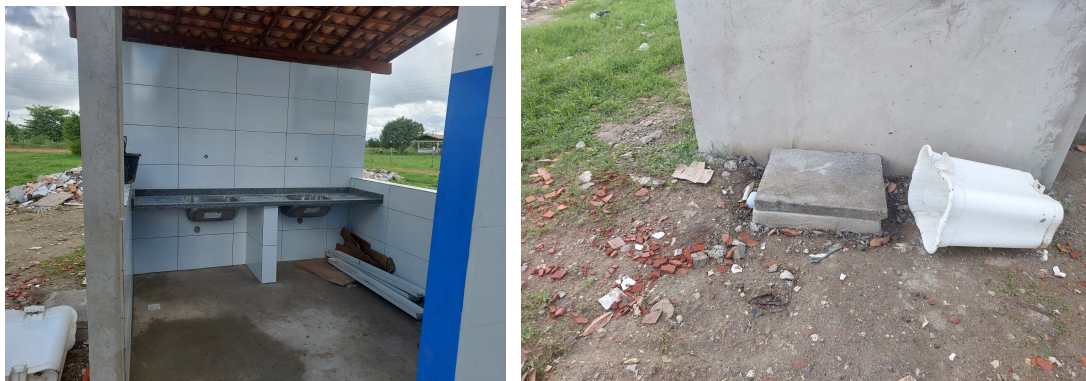
Fotos 04. Execução da lavanderia, com instalação de bancada com tanques de aço inox, pontos de água fria e esgoto. Construção de caixa de passagem. Madeiramento do telhado da lavanderia.
