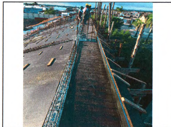
FORMA EM COMPENSADO PLÁSTIFICO PARA LAJE DA ARQUIBANCADA
