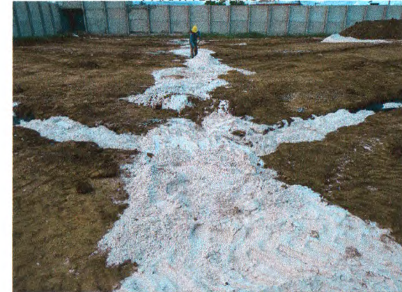
REATERRO MANUAL DE VALAS COM ESPALHAMENTO SEM COMPACTAÇÃO
