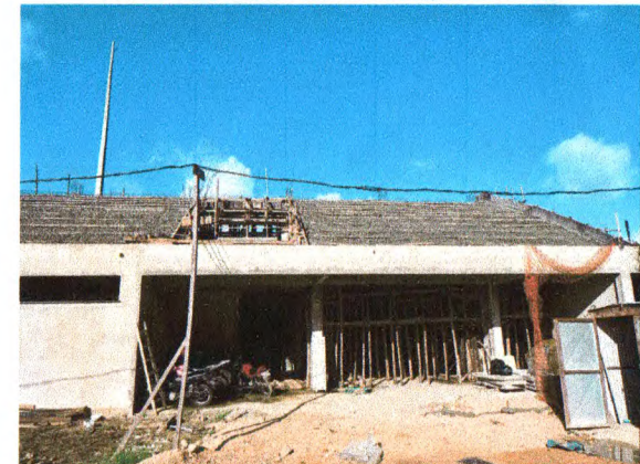
CONCRETAGEM DA ARQUIBANCADA
