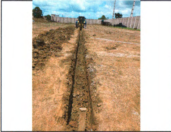
ESCAVAÇÃO DAS TRINCHEIRAS PARA A DRENAGEM
