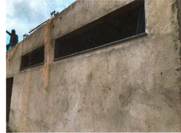
PEITORIL EM GRANITO CINZA POLIDO; REBOCO EXTERNO.
