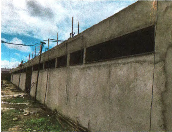
PEITORIL EM GRANITO CINZA POLIDO; REBOCO EXTERNO.
