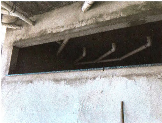
PEITORIL EM GRANITO CINZA POLIDO; REBOCO INTERNO; TUBUS E CONEÇÕES EM PVC DE ESGOTO
