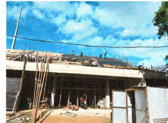
CONTAINER METÁLICO; FORMA EM COMPENSADO PLÁSTIFICO PARA LAJE DA ARQUIBANCADA
