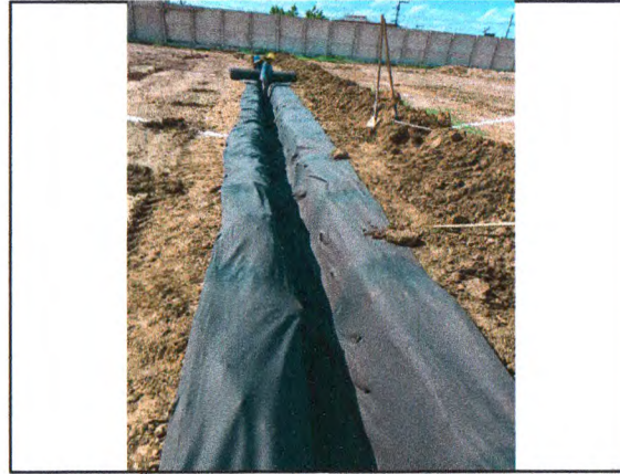
ESCAVAÇÃO E MANTA GEOTEXTIL DAS TRINCHEIRAS PARA A DRENAGEM
