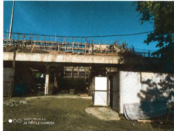
CONTAINER METÁLICO; ESTRUTURA EM CONCRETO ARMADO
