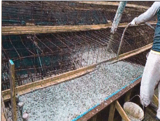
CONCRETAGEM DA ARQUIBANCADA
