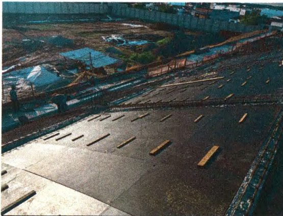
FORMA EM COMPENSADO PLÁSTIFICO PARA LAJE DA ARQUIBANCADA
