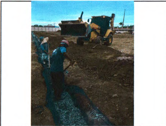
ESCAVAÇÃO, MANTA GEOTEXTIL, LASTRO DE BRITA E TUBO CORRUGADO PERFURADO DAS TRINCHEIRAS PARA A DRENAGEM
