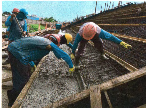
CONCRETAGEM DA ARQUIBANCADA
