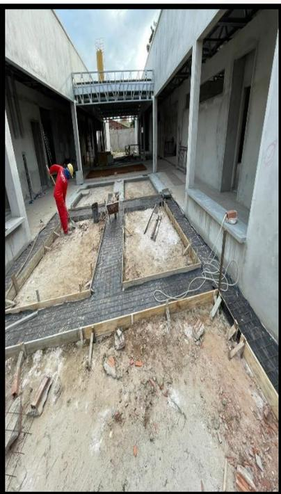
**Figura 05:** Execução de cintamento superior da fossa séptica.
