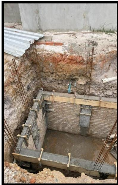
**Figura 02:** Execução de escavação em vala para muro lateral.
