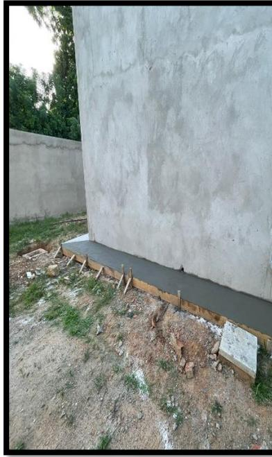
**Figura 15: Base de regularização em alvenaria em pedra.**
