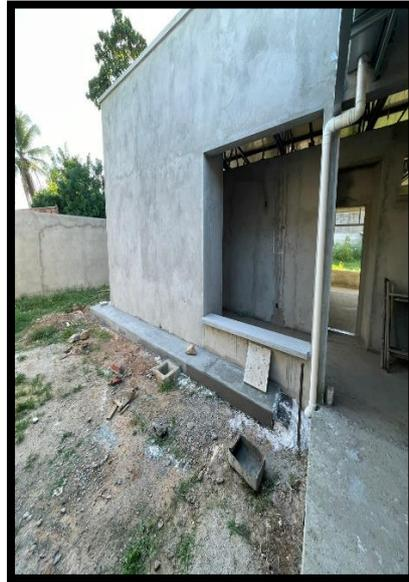
*Figura 09: Execução de passeio externo.*
