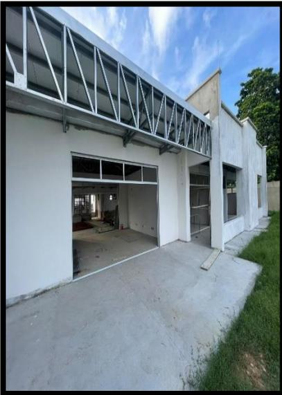
*Figura 35: Aplicação de massa acrílica em ambientes internos e posicionamento de esquadrias.*
