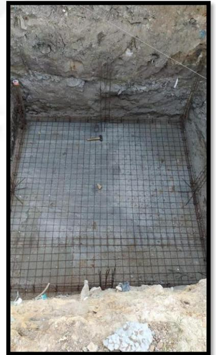
**Figura 13: Execução de alvenaria, armação e concretagem da fossa séptica.**
