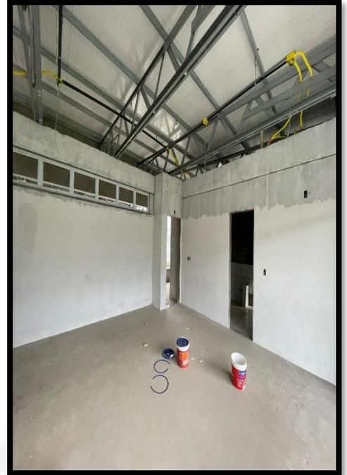
**Figura 28:** Aplicação de massa acrílica em paredes internas.
