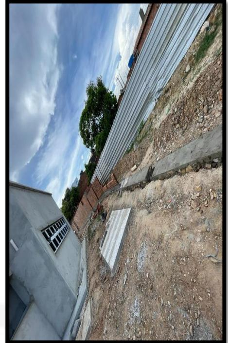
*Figura 22: Execução de cintamento inferior.*
