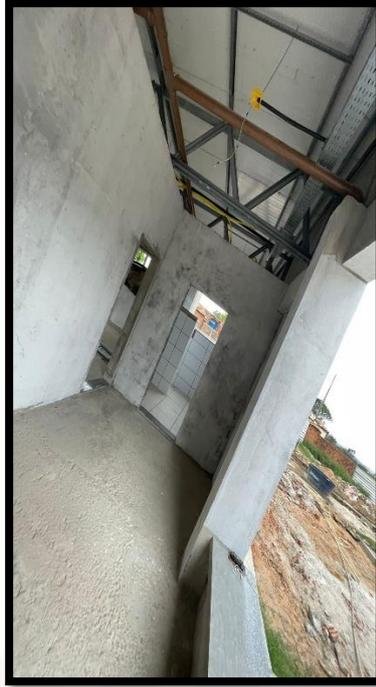
**Figura 27:** Aplicação de massa acrílica em paredes internas e posicionamento de esquadrias.
