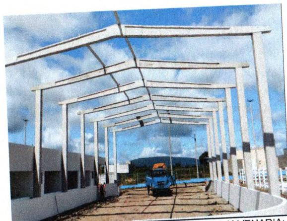
ESTRUTURA PRÉ-MOLDADA; MURETA EM ALVENARIA;
