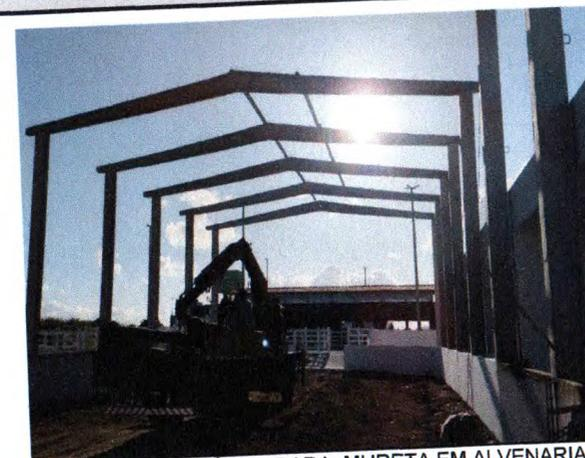
ESTRUTURA PRÉ-MOLDADA; MURETA EM ALVENARIA;
