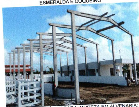
ESTRUTURA PRÉ-MOLDADA; MURETA EM ALVENARIA;
