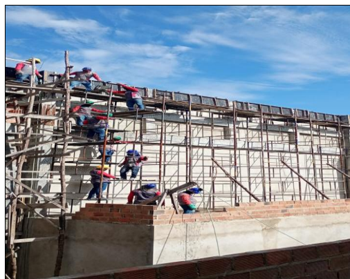
CONCRETAGEM DE VIGAS COBERTURA
