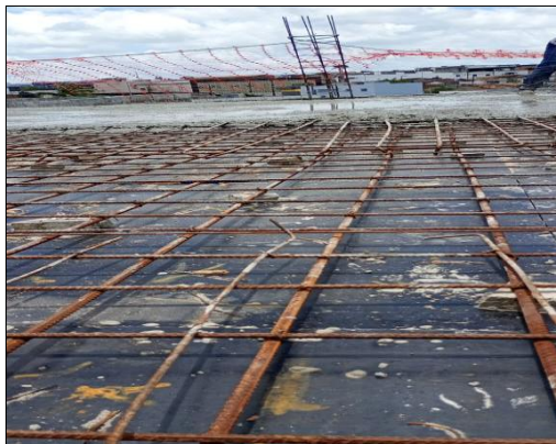
AÇO E CONCRETAGEM LAJE 12,15
