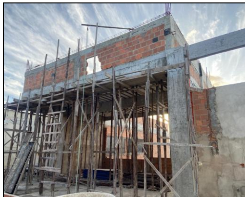
FINALIZAÇÃO DA LAJE 10,35 - VIGA E LAJE 12,15
