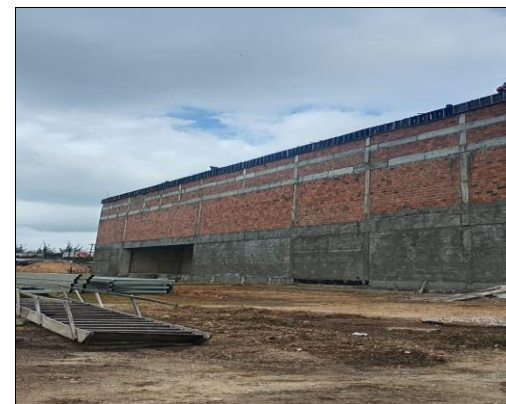
FINALIZAÇÃO DAS VIGAS 12,15 - FORMA E CONCRETAGEM DAS VIGAS COBERTURA
