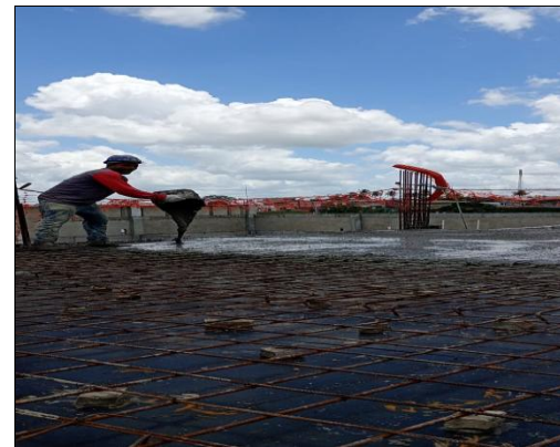
CONCRETAGEM LAJE 12,15
