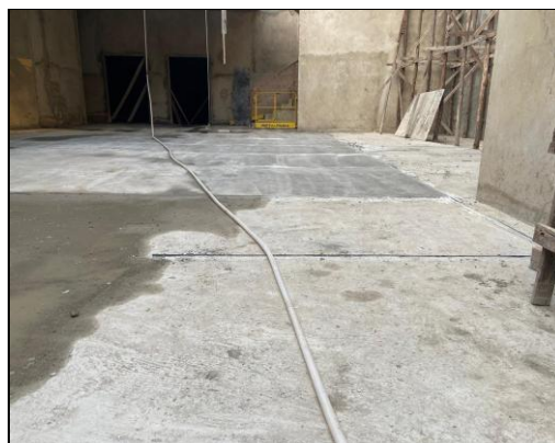
INSTALAÇÃO PISO DE ALTA RESISTÊNCIA - PAVIMENTO TERREO
