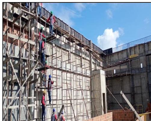
FORMA, ARMAÇÃO E CONCRETAGEM DE VIGAS COBERTURA
