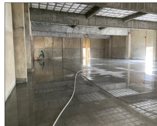
INSTALAÇÃO PISO DE ALTA RESISTÊNCIA - PAVIMENTO TERREO
