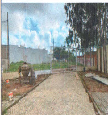
Gradil e portão
