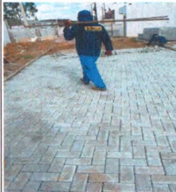
Pavimentação em intertravado
