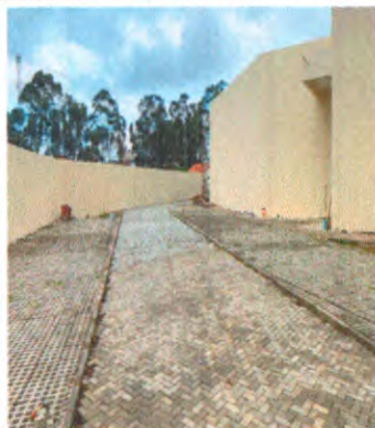
Pintura externa e piso intertravado
