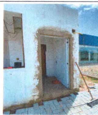
Porta de alumínio da guarita
