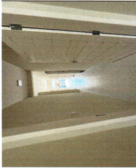
PINTURA E LIMPEZA DA OBRA
