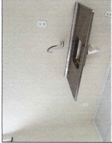
PIA INOX, PINTURA E LIMPEZA DA OBRA
