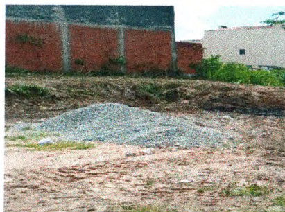
CANAL DA AV. MANOEL FRANCISCO TELES
