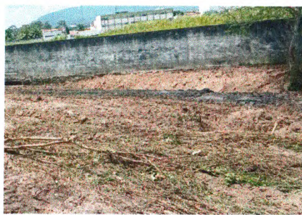
CANAL DA AV. MANOEL FRANCISCO TELES
