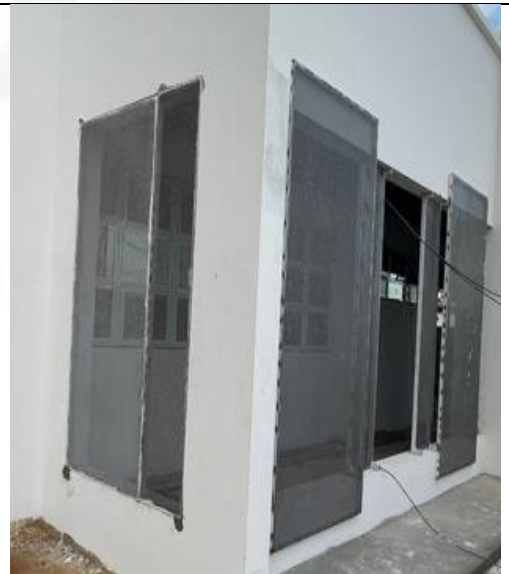
Figura 12: Fixação das esquadrias de chapa de aço perfurada.
