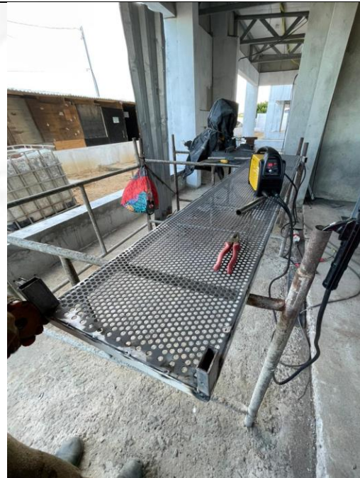
Figura 06: Montagem dos quadros para esquadria de chapa de aço perfurada .
