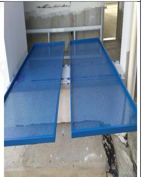
Figura 18: Pintura das esquadrias de chapa de aço perfurada.
