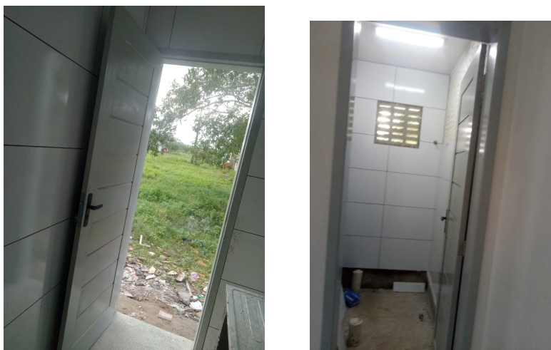
Fotos 07. Execução de revestimento no banheiro e cozinha, luminária, forro de gesso, portas da Casa do Vigia 02
