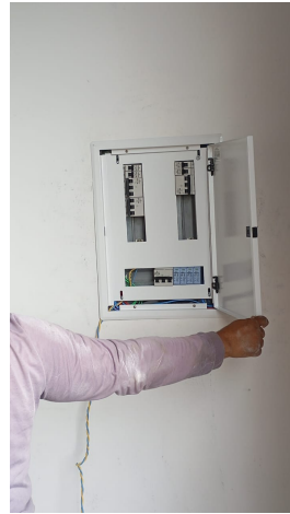
Fotos 11. Quadro de energia com disjuntores do Bloco do Abrigo
