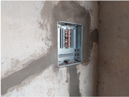
Fotos 11. Quadro de energia com disjuntores do Bloco do Abrigo
