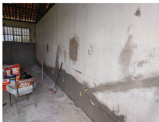
Fotos 10. Instalação de eletrodutos, caixas de passagem e execução de chapisco e reboco
