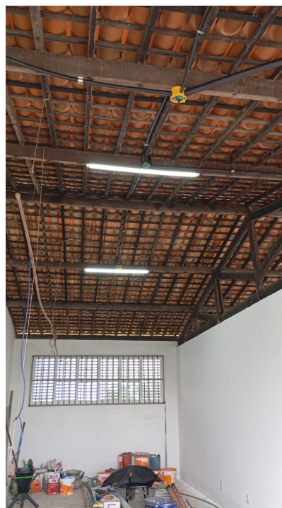
Fotos 12. Instalação de cabeamento, eletrodutos, tomadas, refletores e pintura interna e externa do Abrigo
