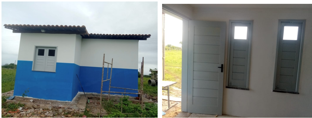
Fotos 06. Pintura externa e interna, pintura de esquadrias e instalação de portas e janelas
