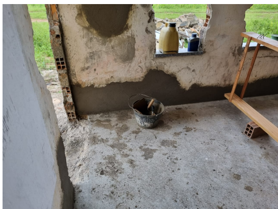
Fotos 01. Demolição e execução de chapisco e reboco na Casa do Vigia 02
