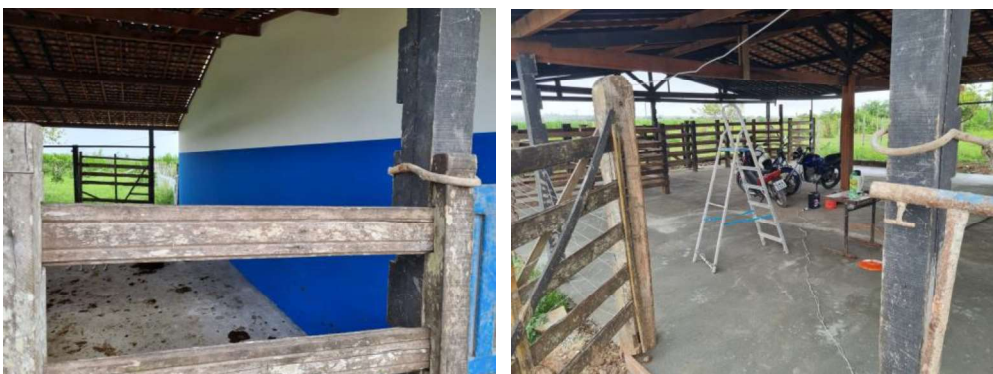
Fotos 14. Execução do piso cimentado do curral e pintura da parte externa do Abrigo
