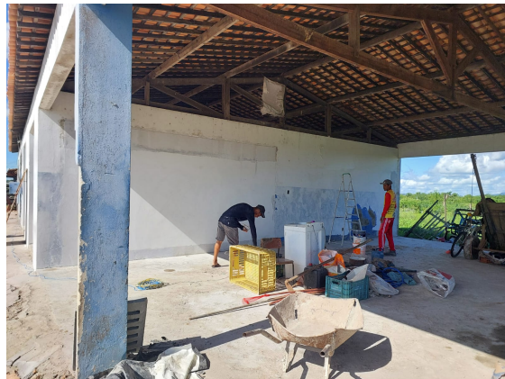
Fotos 09. Execução de chapisco e reboco e início do emassamento e aplicação de selador em todo o Bloco do Abrigo
