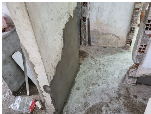
Fotos 01. Demolição e execução de chapisco e reboco na Casa do Vigia 02
