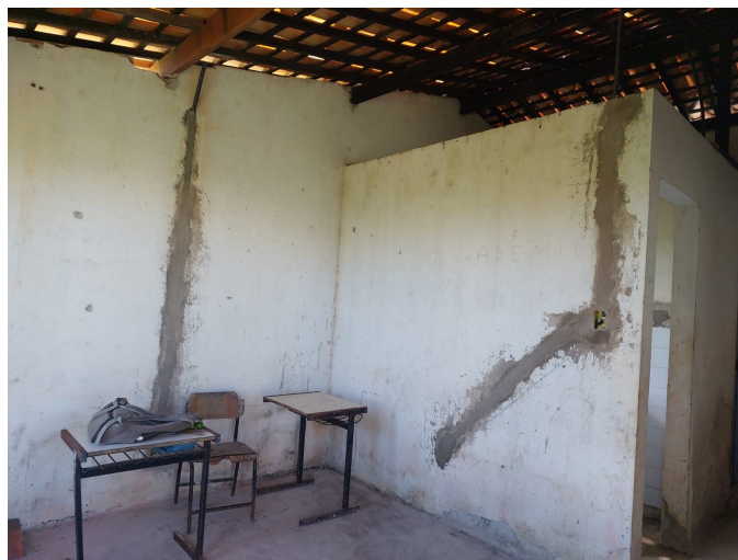
Fotos 04. Instalação de eletrodutos e caixas de passagem
