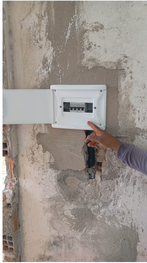
Fotos 03. Instalação de Quadro de Energia e haste de aterramento, com cabeamento, da Casa do Vigia 02
