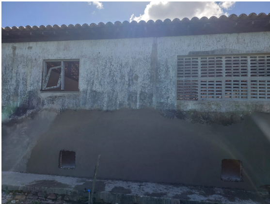
Fotos 09. Execução de chapisco e reboco e início do emassamento e aplicação de selador em todo o Bloco do Abrigo
