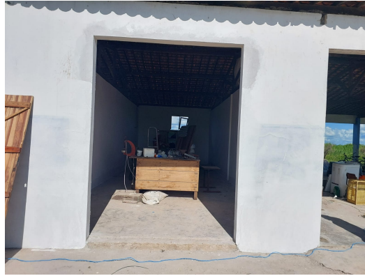
Fotos 08. Aplicação de selador após a execução de chapisco e reboco no Bloco do Abrigo
