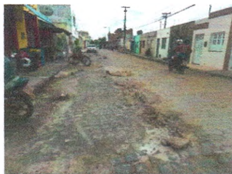
AVENIDA PADRE AIRTON GONÇALVES
