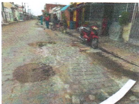
AVENIDA PADRE AIRTON GONÇALVES
