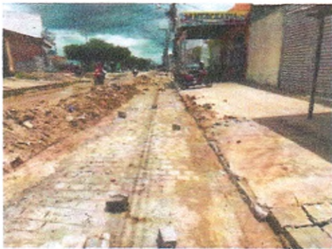
AVENIDA PADRE AIRTON GONÇALVES
