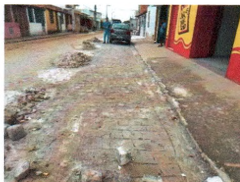
AVENIDA PADRE AIRTON GONÇALVES
