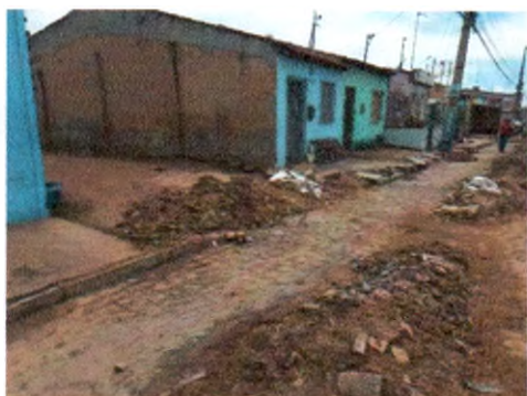
AVENIDA PADRE AIRTON GONÇALVES
