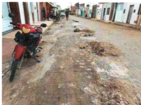
AVENIDA PADRE AIRTON GONÇALVES
