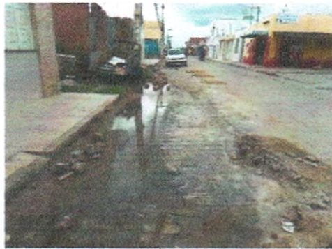
AVENIDA PADRE AIRTON GONÇALVES
