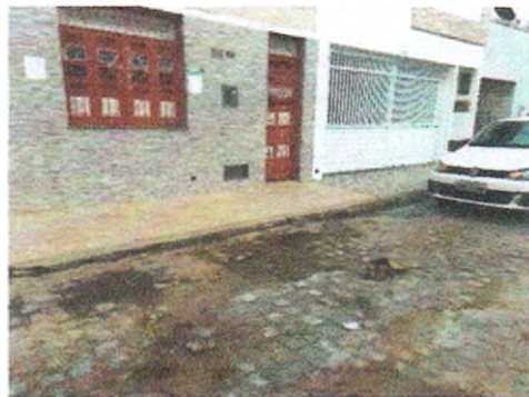
AVENIDA PADRE AIRTON GONÇALVES
