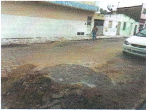
AVENIDA PADRE AIRTON GONÇALVES
