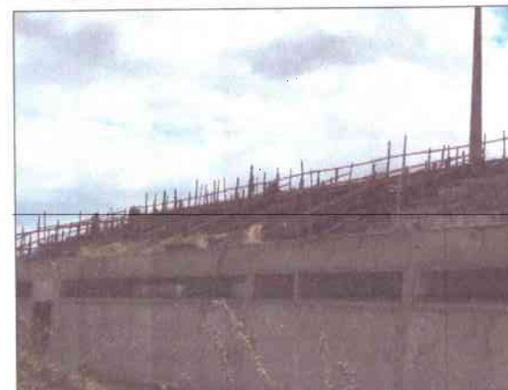
MONTAGEM DAS FORMAS DE FERRAGENS NAS VIGAS INCLINADAS
