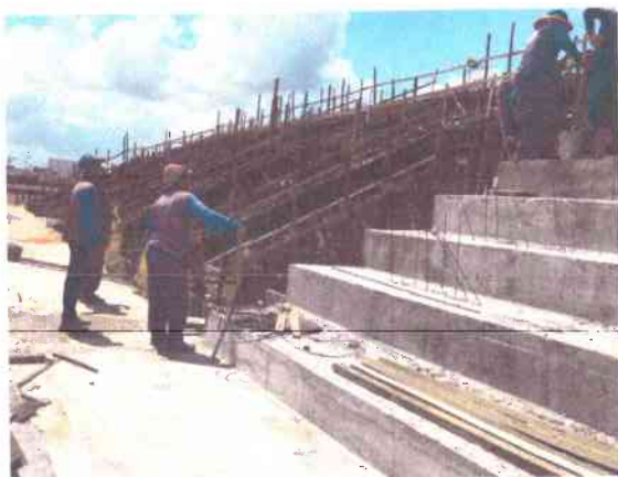
MONTAGEM DAS FORMAS E ESCORAMENTO DE FERRAGENS NAS VIGAS INCLINADAS
