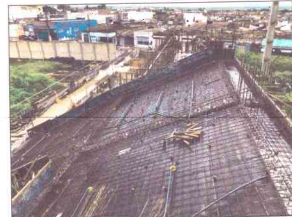
FORMA EM COMPENSADO PLÁSTIFICADO PARA LAJE DA ARQUIBANCADA
