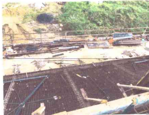
FORMA EM COMPENSADO PLÁSTIFICADO PARA LAJE DA ARQUIBANCADA
