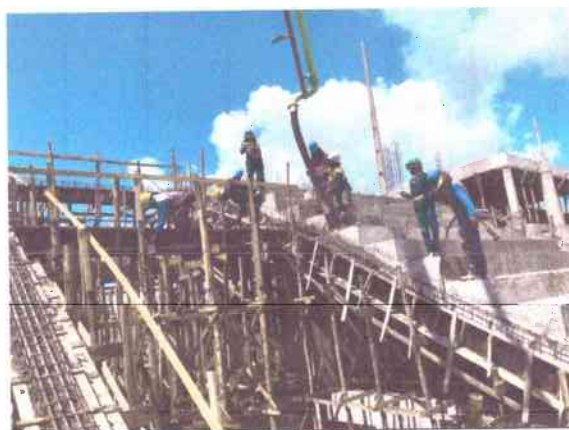
CONCRETAGEM DAS VIGAS INCLINADAS
