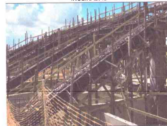
CONCRETAGEM DAS VIGAS INCLINADAS; PILARES EM CONCRETO ARMADO
