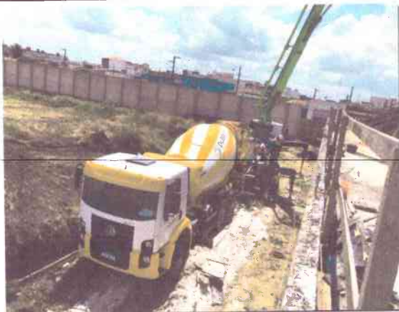
CONCRETAGEM DA ARQUIBANCADA
