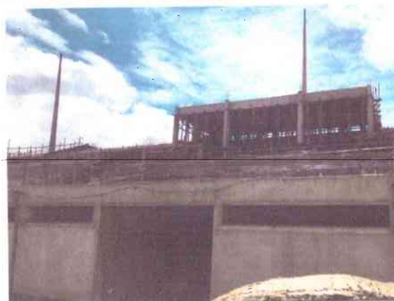
CONCRETAGEM DA ARQUIBANCADA
