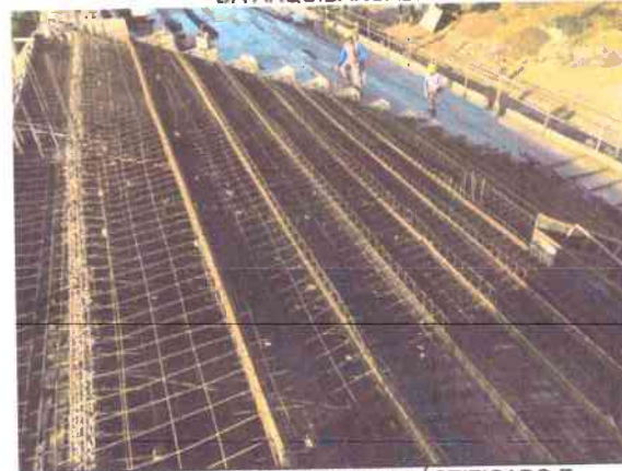
FORMA EM COMPENSADO PLÁSTIFICADO E FERRAGENS DA LAJE DA ARQUIBANCADA
