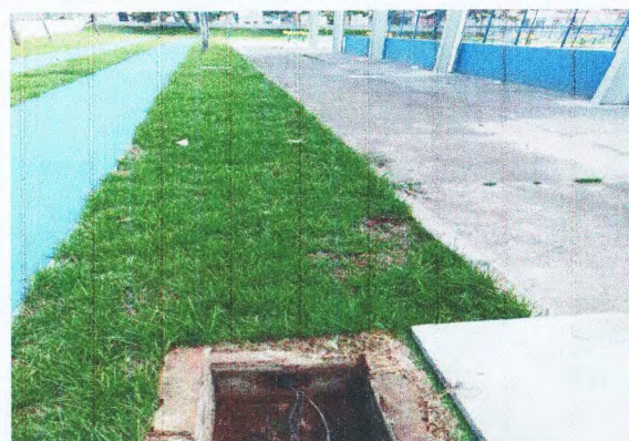
CAIXA DE ALVENARIA
