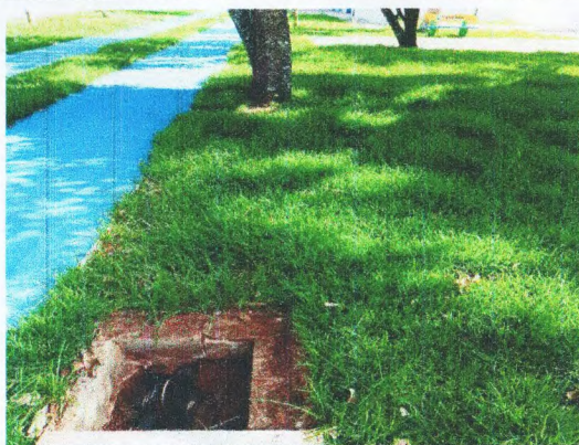
CAIXA DE ALVENARIA
