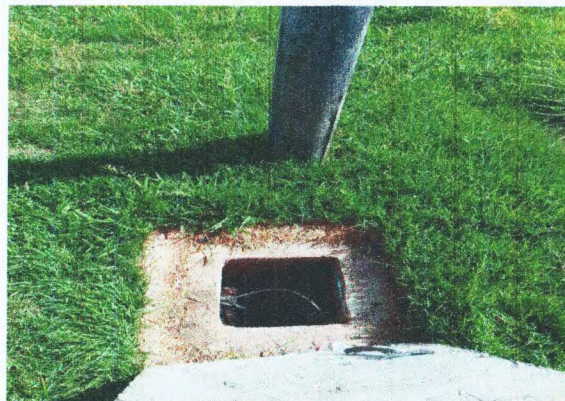
CAIXA DE ALVENARIA
