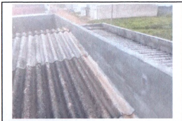
EMASSAMENTO DE ALGEROZ E REVISÃO EM TELHADO DE FIBROCIMENTO
