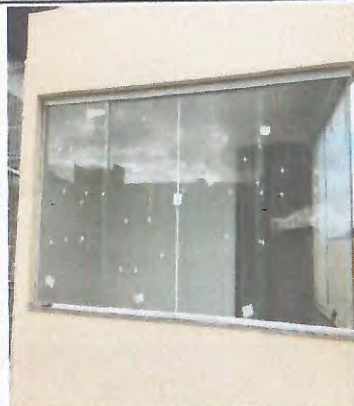
VIDROS E PINTURAS GUARITA
