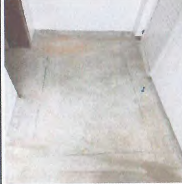
PISO DE ALTA RESISTÊNCIA DA GUARITA
