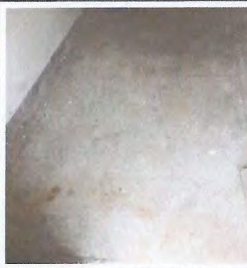
PISO DE ALTA RESISTÊNCIA CASA DE LIXO
