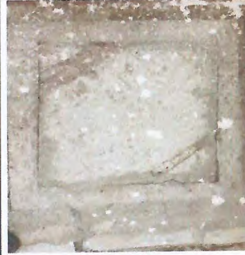
CAIXA DE PASSAGEM
