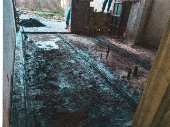
REGULARIZAÇÃO DA BASE DO PISO
