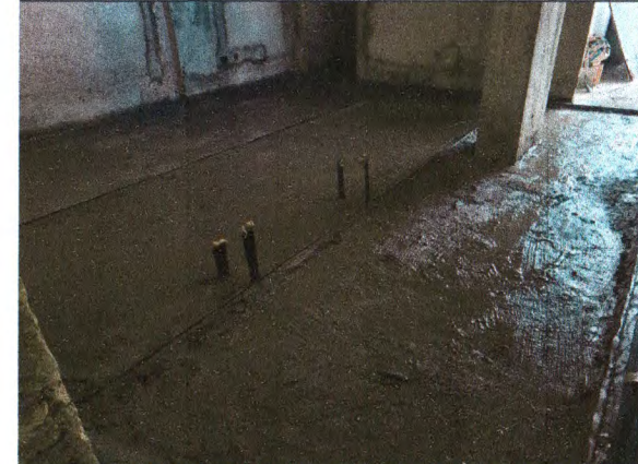
REGULARIZAÇÃO DA BASE DO PISO
