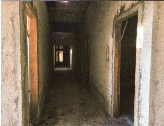
INSTALAÇÃO DOS BATENTES DAS PORTAS; PAREDE CHAPISCADA E REBOCADA
