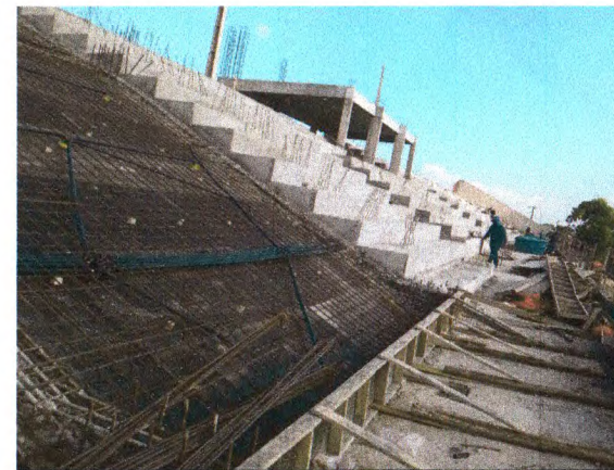
FORMA; TELA DE AÇO NERVURADO SOBRE A LAJE
