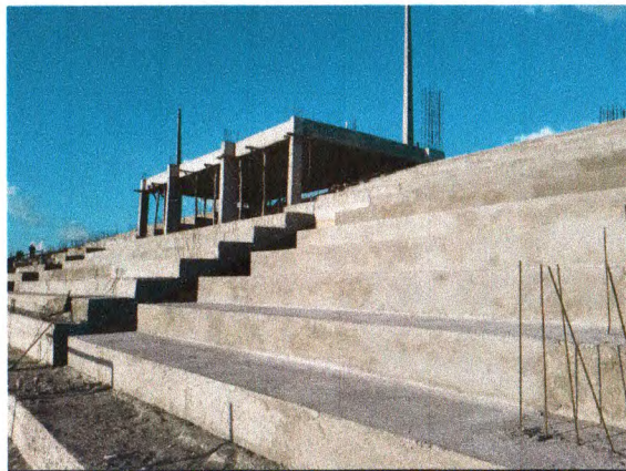
VIGAS; ARQUIBANCADA; LAJE CONCRETADAS
