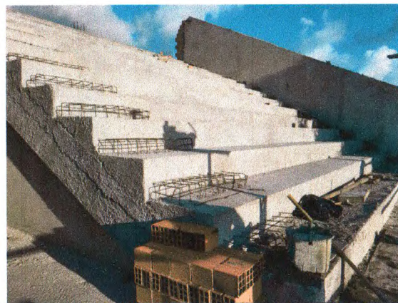
VIGAS; ARQUIBANCADA; LAJE CONCRETADAS
