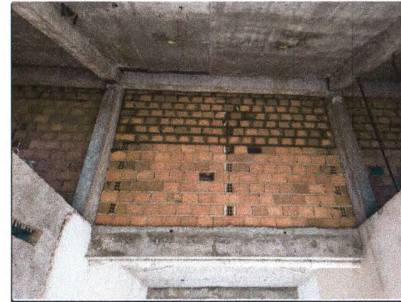
PAREDE EM ALVENARIA DE BLOCO CERÂMICO
