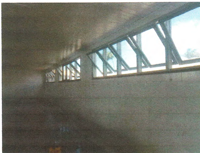
Fotos 06. Pintura de esquadrias de madeira
