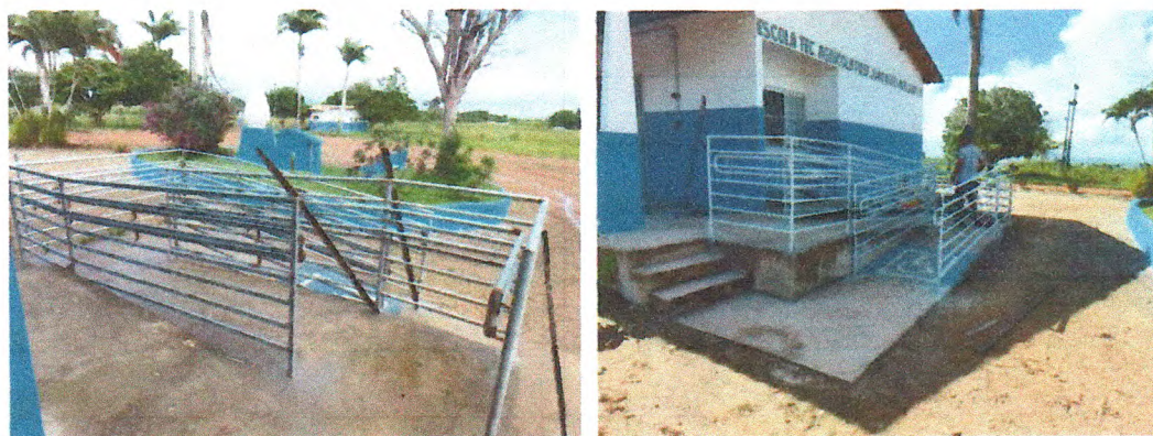
Fotos 07. Montagem e pintura do corrimão e guarda-corpo da entrada da Escola
