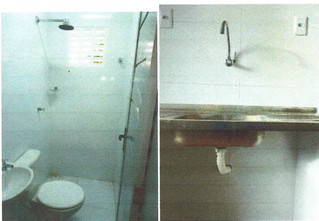
Fotos 08. Instalação dos acessórios no banheiro e cozinha da Casa do Vigia 02
