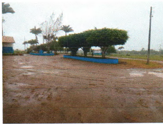
Fotos 11. Reboco, emassamento e pintura dos canteiros da Escola
