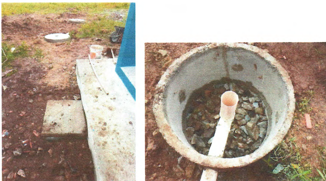
Fotos 02. Instalação da fossa séptica e filtro da Casa do Vigia 02
