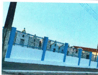
MURO EM FRENTE AO CEMITERIO PÉ DO VEADO
