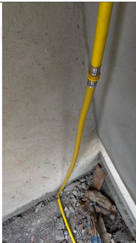
Figura 47: Instalação dos componentes de gás.
