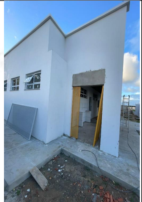
Figura 36: Emassamento e pintura das esquadrias metálicas.
