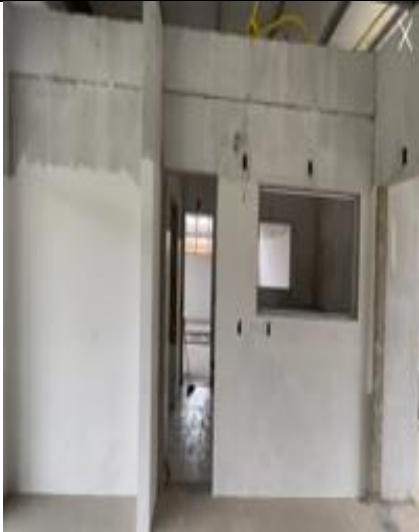
Figura 10: Aplicação de fundo selador e emassamento.
