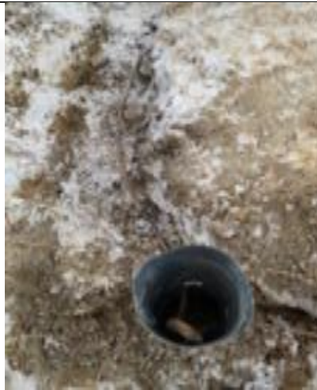
Figura 29: Fixação das cordoalhas.
