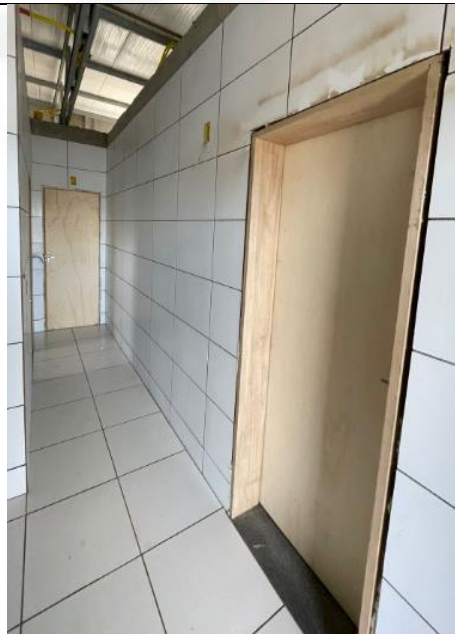
Figura 53: Instalação de porta de madeira.
