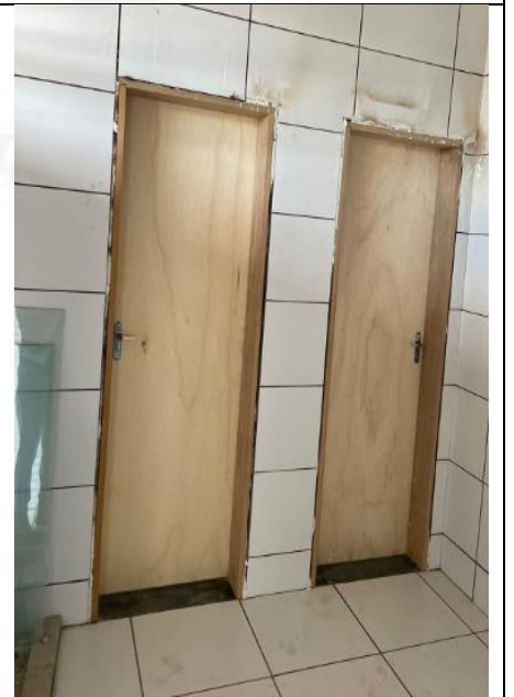
Figura 54: Instalação de porta de madeira.
