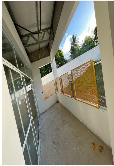
Figura 59: Instalação de porta de alumínio e pintura das esquadrias.
