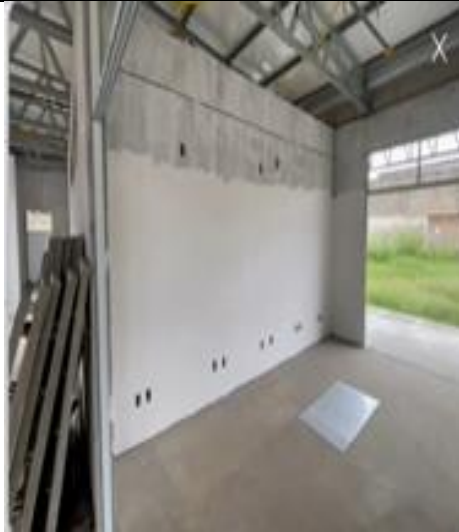
Figura 11: Aplicação de fundo selador e emassamento.
