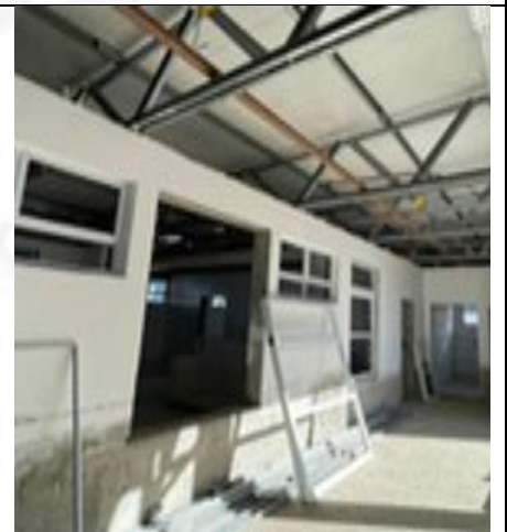
Figura 18: Aplicação de fundo selador e emassamento.
