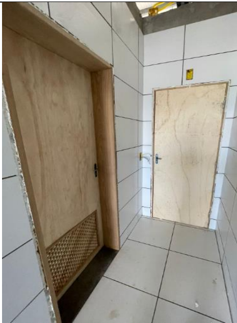
Figura 52: Instalação de porta de madeira.
