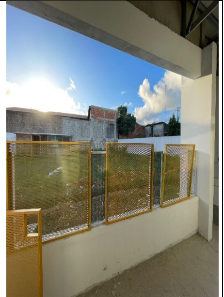
Figura 57: Pintura das esquadrias metálicas.
