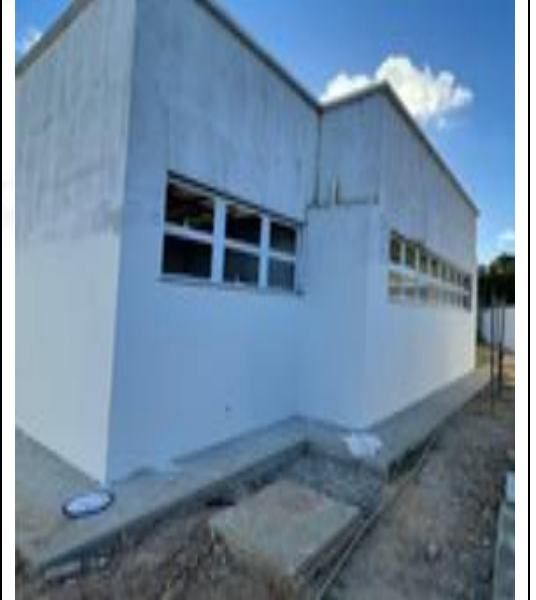
Figura 06 Aplicação de fundo selador, emassamento.
