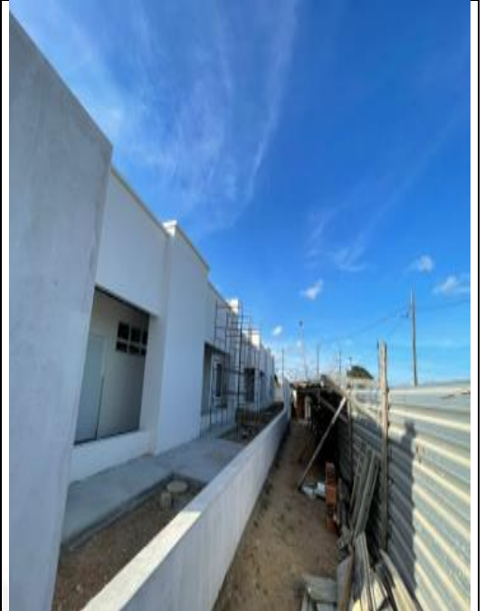
Figura 06 Aplicação de fundo selador, emassamento.
