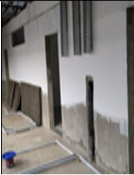
Figura 13: Aplicação de fundo selador e emassamento.
