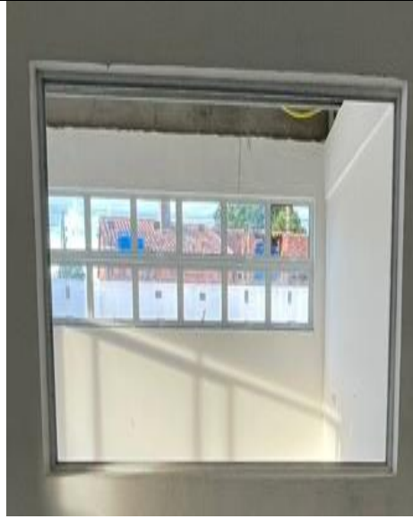
Figura 26: Instalação das janelas e vidros.
