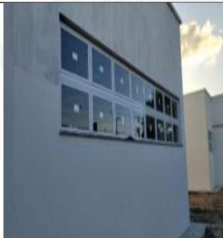
Figura 17: Instalação das janelas e vidros.
