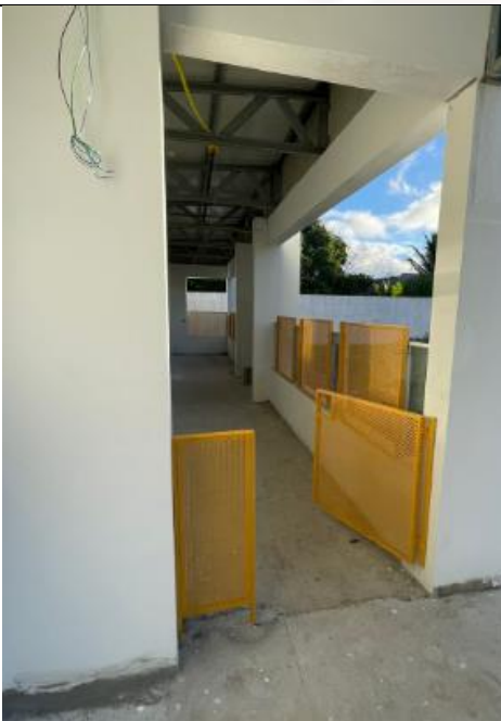
Figura 58: Pintura das esquadrias metálicas.
