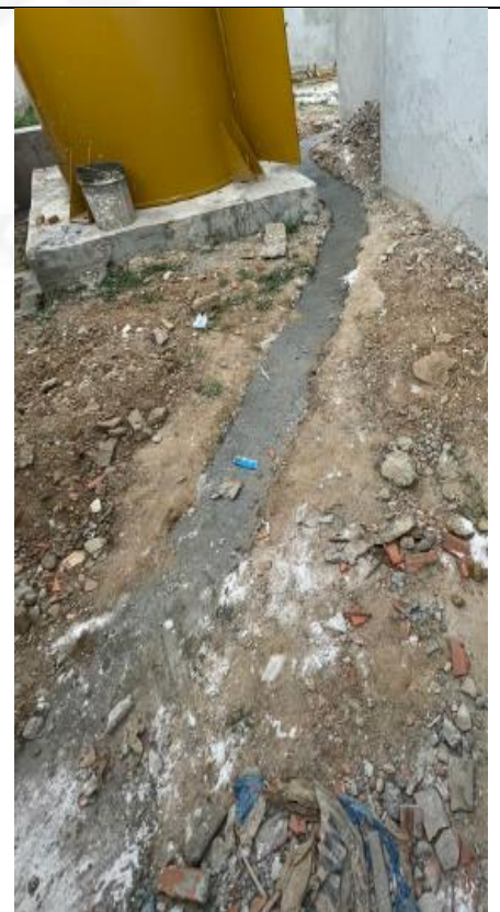
Figura 48: Concretagem da instalação de gás.
