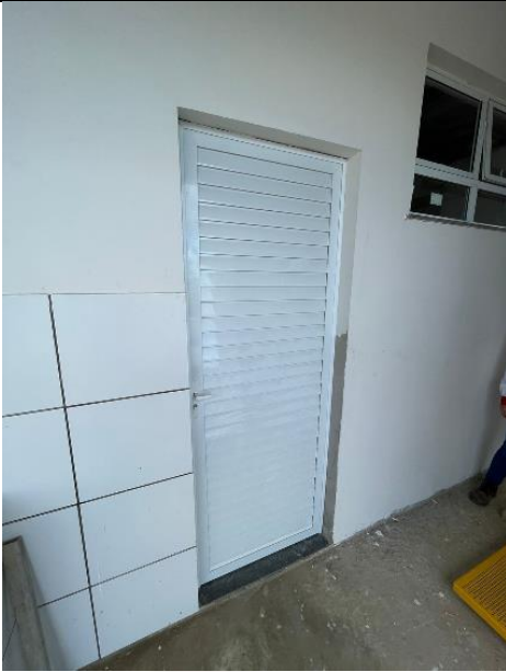
Figura 58: Pintura das esquadrias metálicas.
