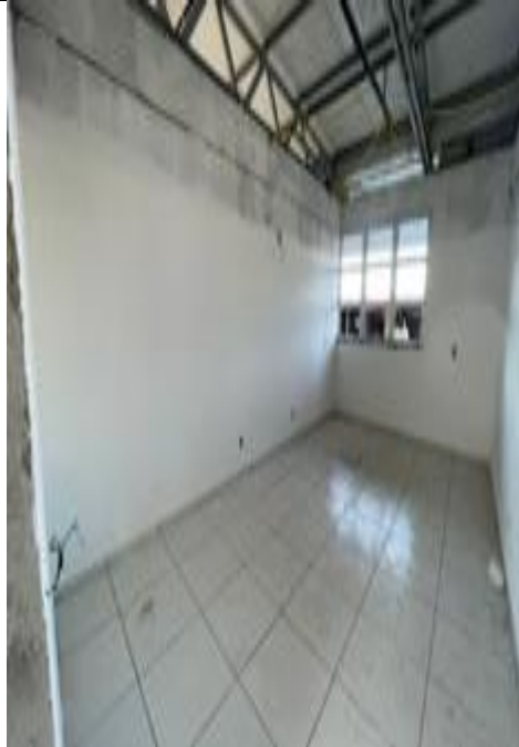
Figura 04: Aplicação de fundo selador, massa acrílica e instalação de porta de vidro
