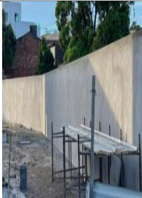
Figura 41: Aplicação de fundo selador.
