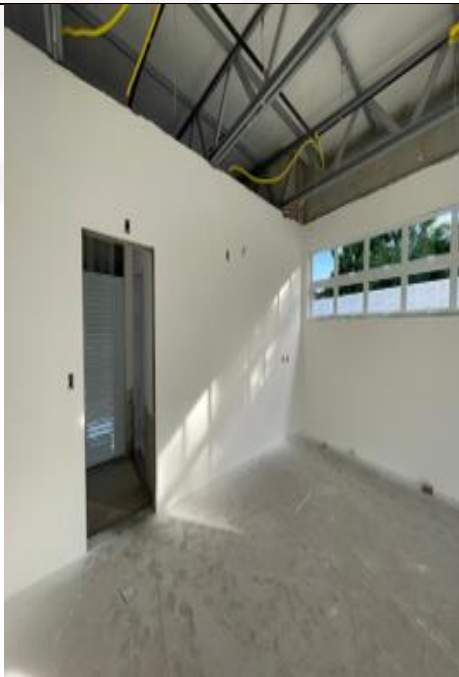
Figura 11: Aplicação de fundo selador e emassamento.
