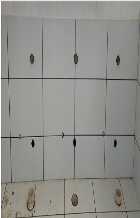
Figura 46: Instalação dos componentes de gás.
