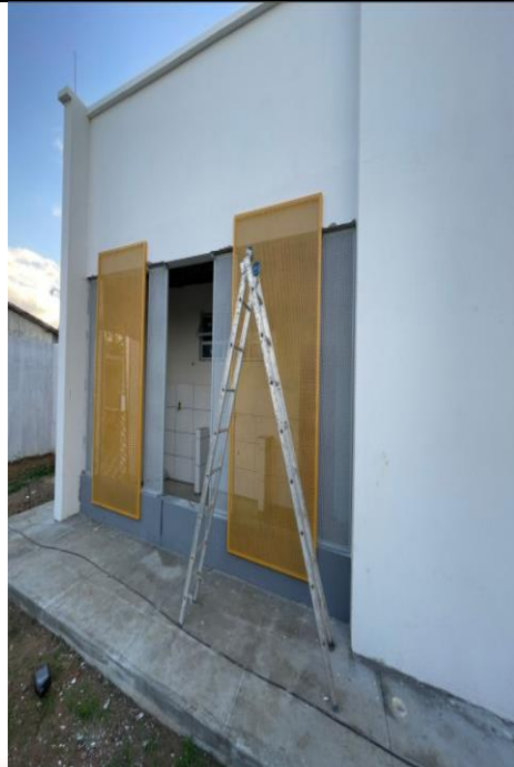
Figura 50: Emassamento externo e pintura das esquadrias de ferro.
