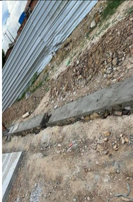
Figura 38: Execução de alvenaria de pedra calcária.
