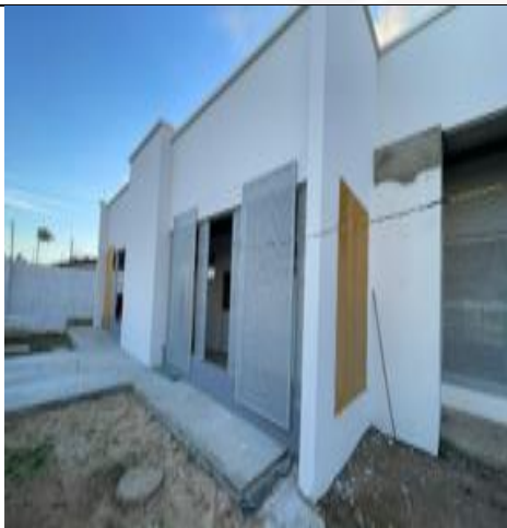
Figura 16: Pintura das esquadrias de ferro.
