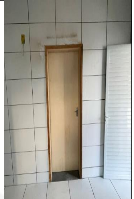
Figura 51: Instalação de porta de madeira e porta de alumínio.
