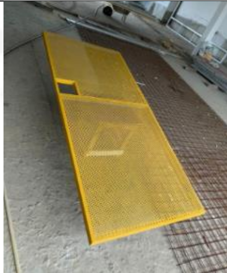
Figura 35: Pintura da esquadria de ferro.
