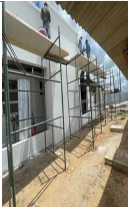
Figura 10: Aplicação de fundo selador e emassamento.
