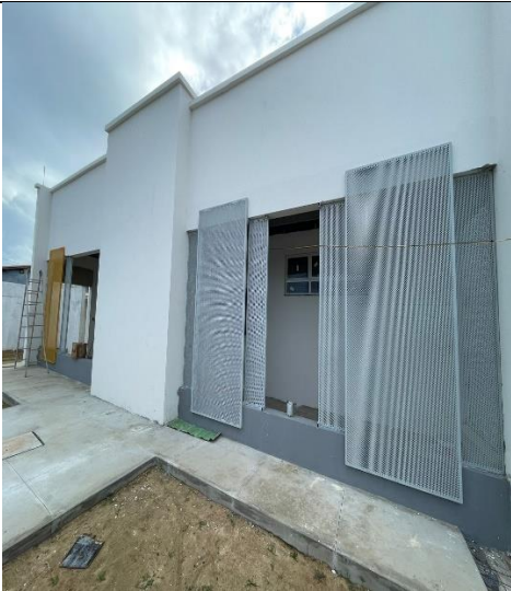
Figura 34: Pintura das esquadrias de ferro e emassamento externo.
