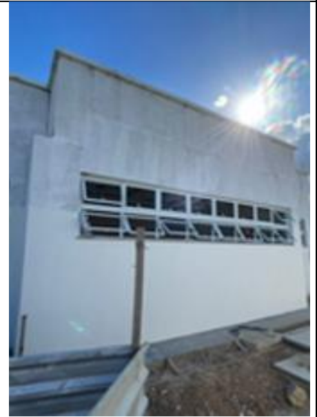
Figura 15: Aplicação de fundo selador e emassamento.
