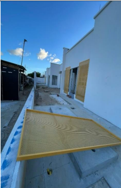
Figura 40: Pintura das esquadrias metálicas.
