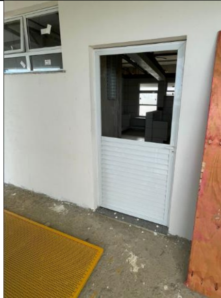
Figura 59: Instalação de porta de alumínio e pintura das esquadrias.
