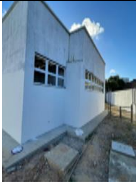
Figura 14: Aplicação de fundo selador e emassamento.
