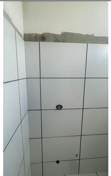
Figura 48: Concretagem da instalação de gás.
