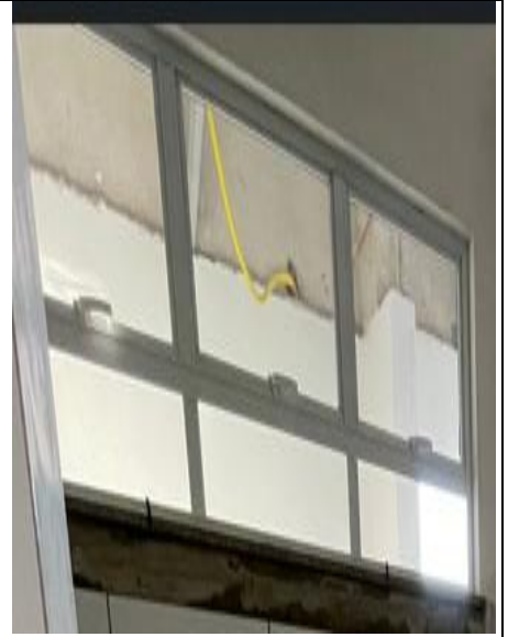
Figura 27: Instalação das janelas e vidros.
