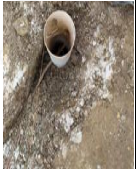
Figura 30: Fixação das cordoalhas.
