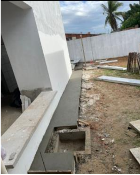
Figura 25: Execução de passeio.
