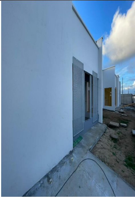
Figura 49: Emassamento externo e pintura das esquadrias de ferro.
