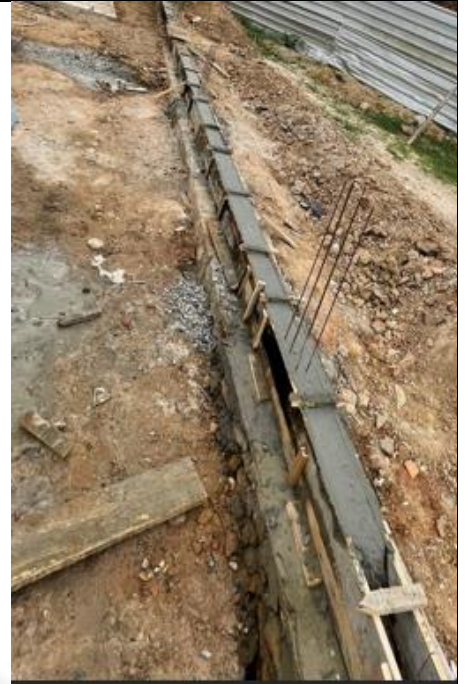
Figura 39: Execução de alvenaria de pedra calcária.
