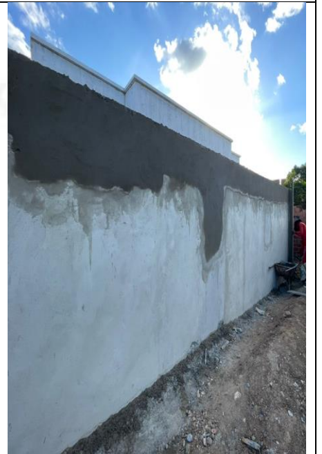
Figura 42: Aplicação de fundo selador no muro.
