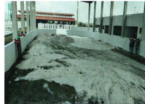
PINTURA DA MURETA; EXECUÇÃO DO COLCHÃO DE AREIA E PÓ DE BRITA
