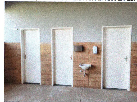
BAIAS COBERTAS - REVESTIMENTO CERÂMICO; LOUÇAS E METAIS; SABONETEIRA E PAPELEIRA; PINTURA INTERNA; PORTA DE MADEIRA
