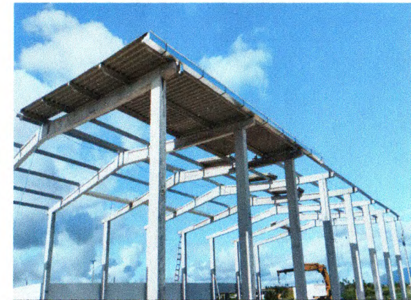
ESTRUTURA PRÉ-MOLDADA; MURETA EM ALVENARIA; PINTURA EXTERNA
