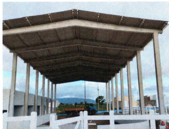
ESTRUTURA PRÉ-MOLDADA; MURETA EM ALVENARIA; PINTURA EXTERNA
