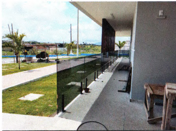
ADMINISTRAÇÃO - BRISE EM MADEIRA DE LEI; PINTURA EXTERNA; VIDRO E FERRAGENS; LUMINÁRIA DE EMERGÊNCIA; PISO EM ALTA RESISTÊNCIA
