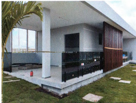
ADMINISTRAÇÃO - BRISE EM MADEIRA DE LEI; PINTURA EXTERNA; VIDRO E FERRAGENS
