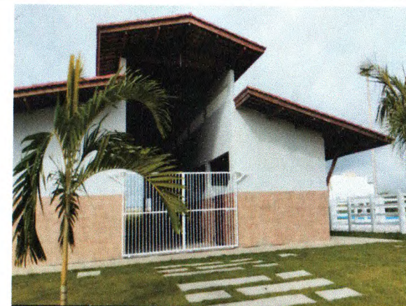
BAIAS COBERTAS - PINTURA EXTERNA; REVESTIMENTO CERÂMICO; PORTÃO METÁLICO; GRAMA ESMERALDA
