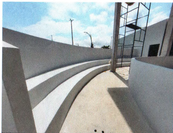
ARQUIBANCADA - PINTURA EXTERNA; MURETA EM ALVENARIA; PISO EM CONCRETO DESMOLADO
