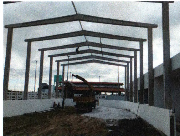
ESTRUTURA PRÉ-MOLDADA; MURETA EM ALVENARIA; PINTURA EXTERNA
