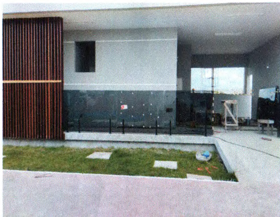
ADMINISTRAÇÃO - BRISE EM MADEIRA DE LEI; PINTURA EXTERNA; VIDRO E FERRAGENS
