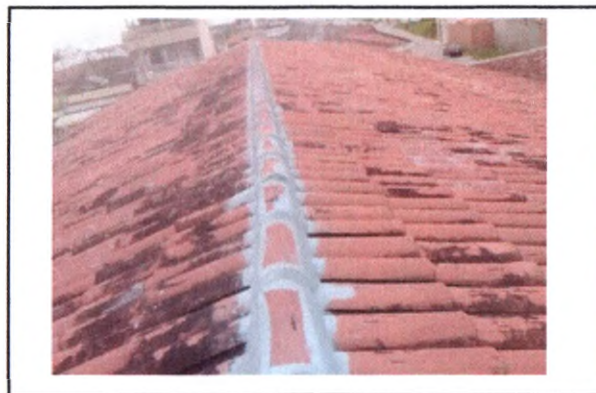
REVISÃO DE COBERTURA COM TELHA CERÂMICA
