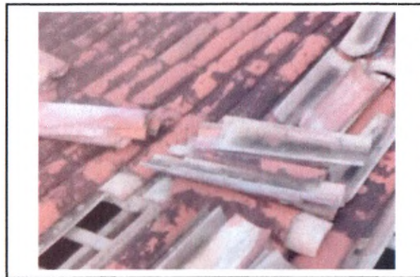
REVISÃO DE COBERTURA COM TELHA CERÂMICA
