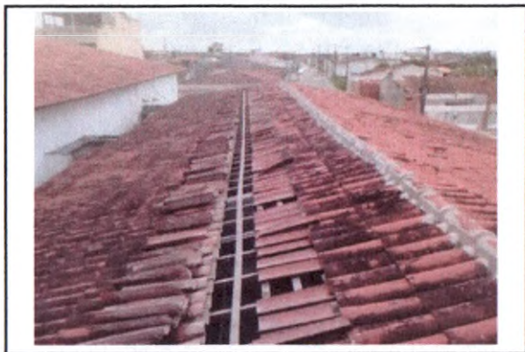
REVISÃO DE COBERTURA COM TELHA CERÂMICA
