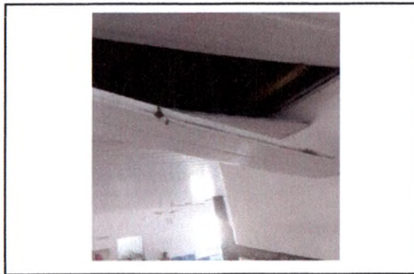
FORRO DE PVC
