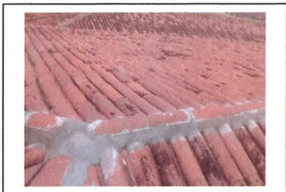
REVISÃO DE COBERTURA COM TELHA CERÂMICA
