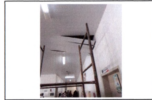
FORRO DE PVC
