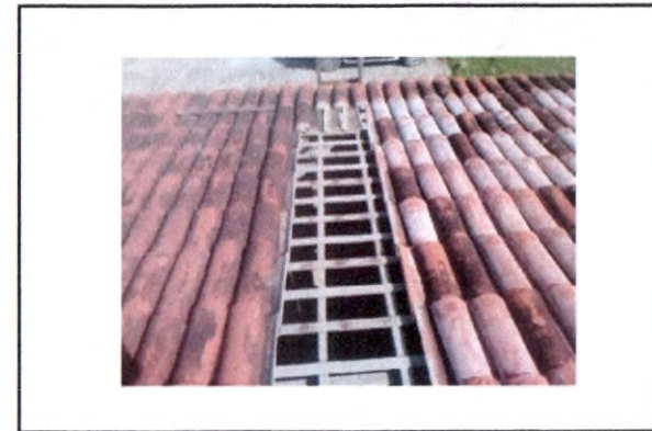
REVISÃO DE COBERTURA COM TELHA CERÂMICA
