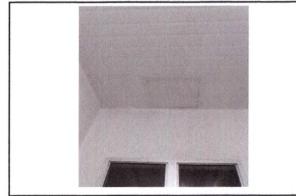
FORRO DE PVC
