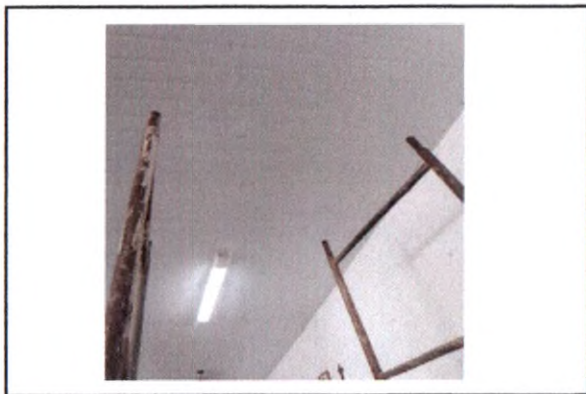
FORRO DE PVC
