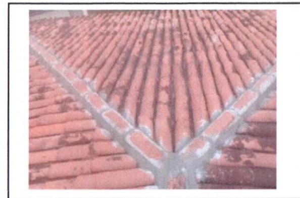
REVISÃO DE COBERTURA COM TELHA CERÂMICA
