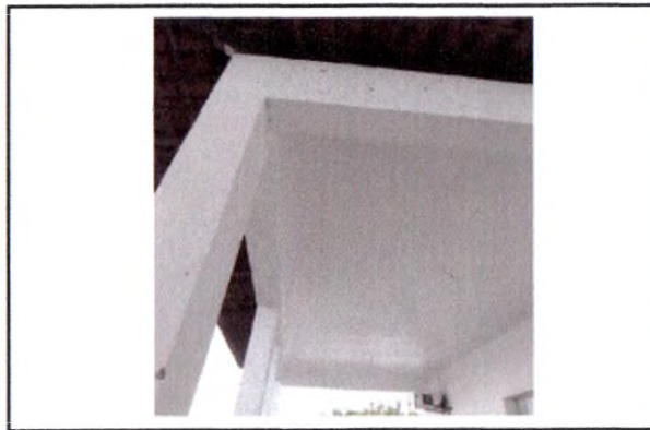
FORRO DE PVC
