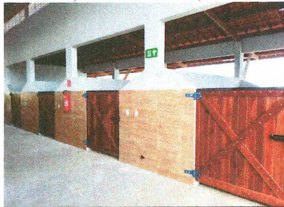
BAIAS COBERTAS - PISO EM CONCRETO DESEMPOLADO; REVESTIMENTO CERÂMICO; PORTÕES DE MADEIRA; EXTINTOR E SINALIZAÇÃO DE EMERGÊNCIA
