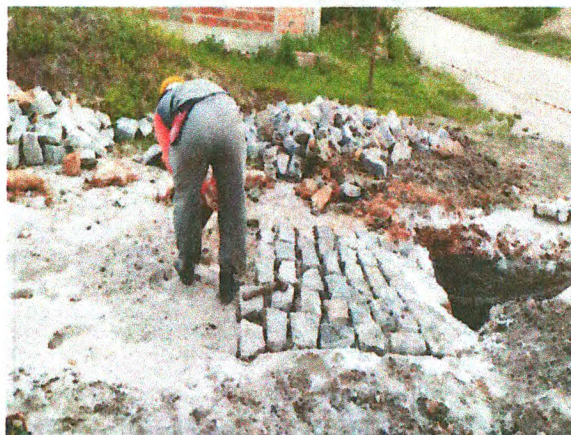
DRENAGEM EXTERNA - REASSENTAMENTO DO PARALELEPÍEDO
