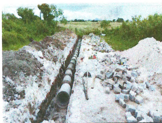
DRENAGEM EXTERNA - REMOÇÃO DE PARALELEPÍPEDO; ESCAVAÇÃO; ASSENTAMENTO DE TUBO DE CONCRETO
