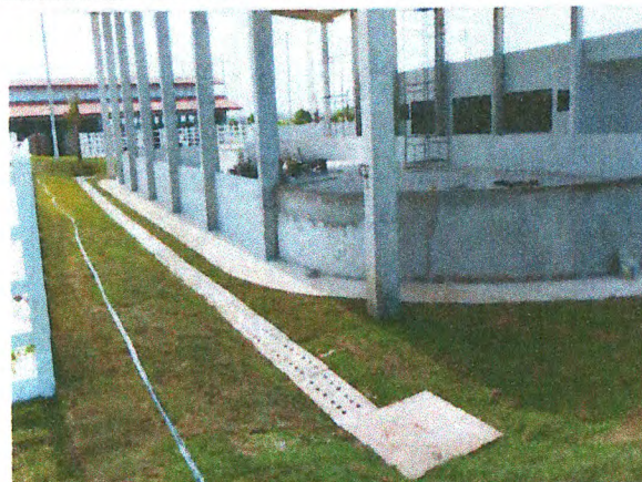
DRENAGEM INTERNA - CALHA DE CONCRETO COM TAMPA; CAIXA DE PASSAGEM
