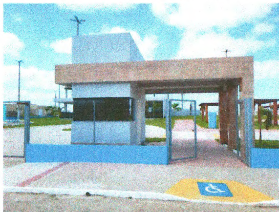
GUARITA; CALÇADA EXTERNA; RAMPA DE ACESSO DEFICIENTE; MURETA E GRADIL METÁLICO
