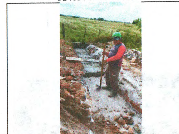
DRENAGEM EXTERNA - REMOÇÃO DE PARALELEPÍPEDO; ESCAVAÇÃO; ASSENTAMENTO DE TUBO DE CONCRETO; REATERRO; LASTRO DE CONCRETO
