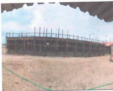
EXECUÇÃO DE LAJE
