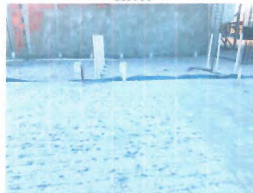
ALVENARIA DE VEDAÇÃO - CHAPISCO - INSTALAÇÕES HIDROSANITÁRIAS
