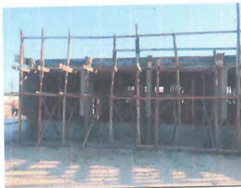
EXECUÇÃO DE LAJE
