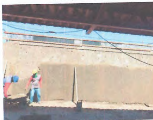
CHAPISCO, EMBOÇO, REBOCO - FORMA/CONCRETAGEM DE VIGA
