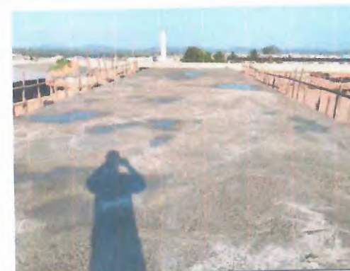
EXECUÇÃO DE LAJE
