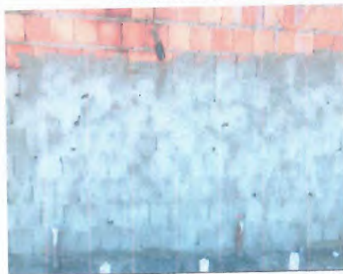
CHAPISCO - ALVENARIA DE VEDAÇÃO
