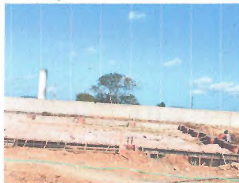
ATERRO - FORMA E CONCRETAGEM DE VIGAS E BLOCOS
