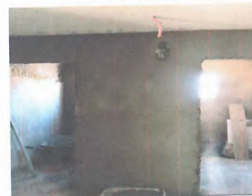
CHAPISCO, EMBOÇO, REBOCO
