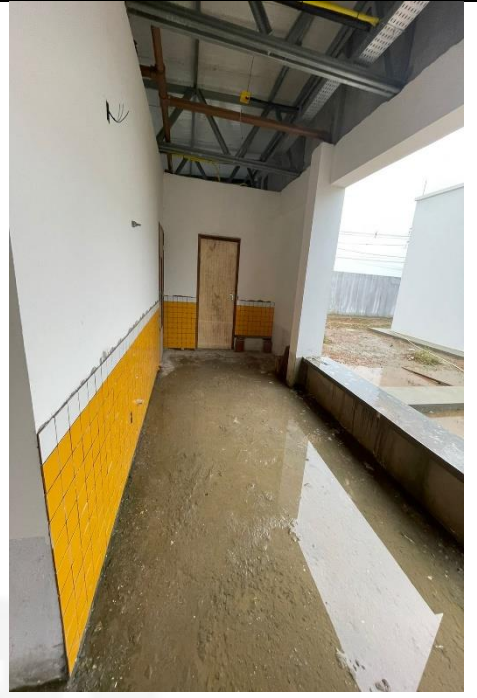
Figura 12: Assentamento de revestimento cerâmico 10x10.
