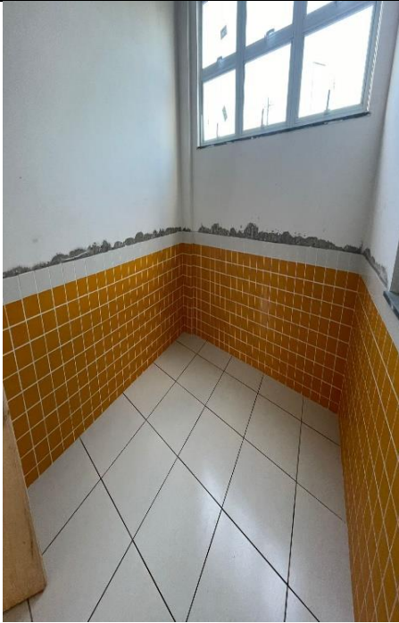
Figura 10: Assentamento de revestimento cerâmico 10x10 e instalação das portas.
