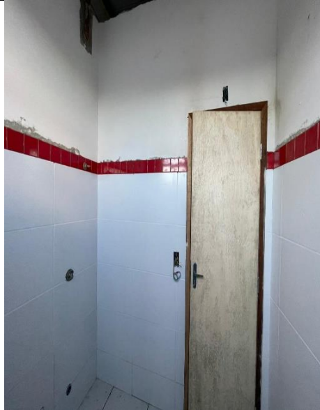
Figura 05: Assentamento do revestimento cerâmico 10x10.
