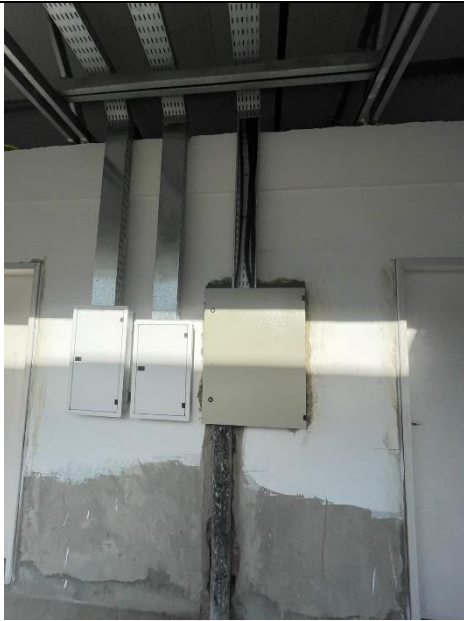
Figura 25: Passagem dos eletrodutos, cabos e montagem do QD e QDG.
