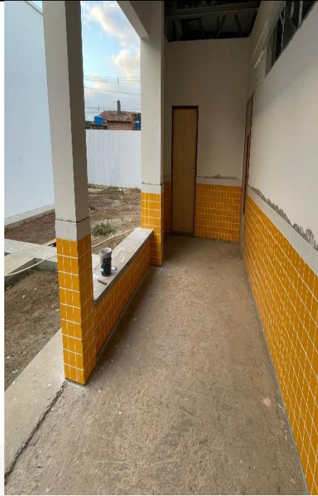
Figura 11: Assentamento de revestimento cerâmico 10x10 e instalação das portas.
