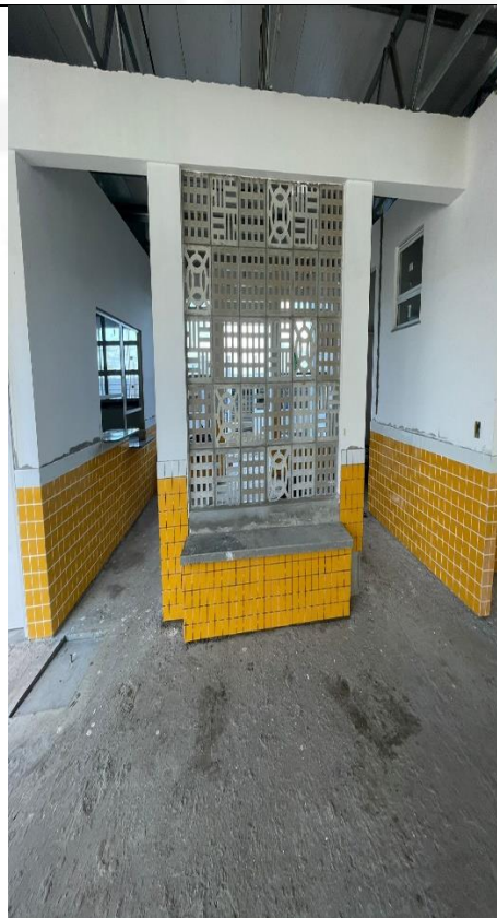
Figura 17: Assentamento do revestimento cerâmico 10x10.
