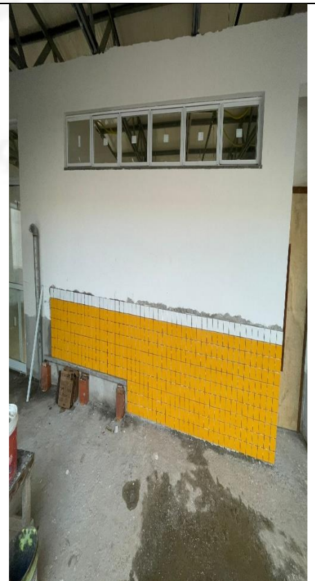
Figura 18: Assentamento do revestimento cerâmico 10x10.
