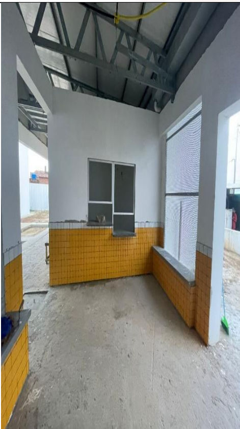
Figura 16: Assentamento do revestimento cerâmico 10x10.
