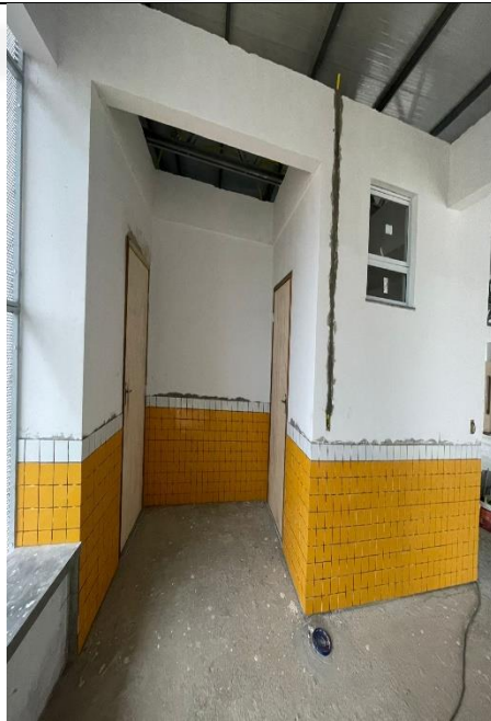
Figura 11: Assentamento de revestimento cerâmico 10x10 e instalação das portas.
