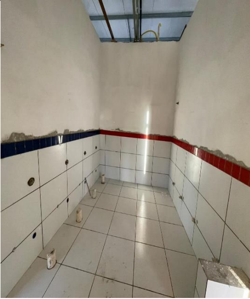
Figura 04: Assentamento do revestimento cerâmico 10x10.
