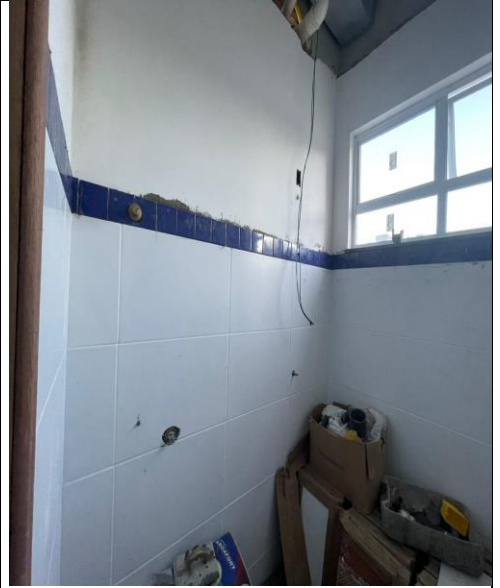
Figura 06: Assentamento do revestimento cerâmico 10x10.
