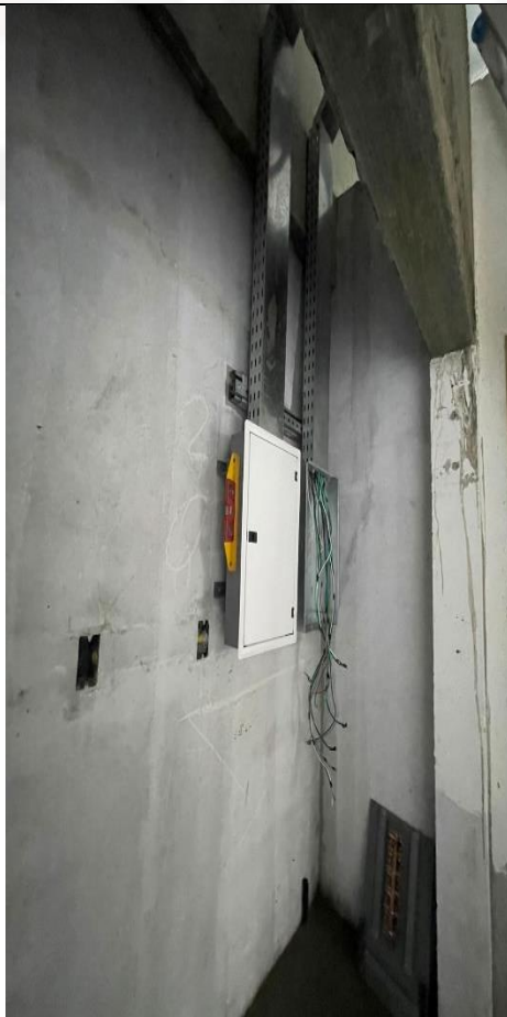
Figura 23: Passagem dos eletrodutos, cabos e montagem do QD.
