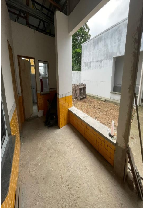
Figura 16: Assentamento do revestimento cerâmico 10x10.
