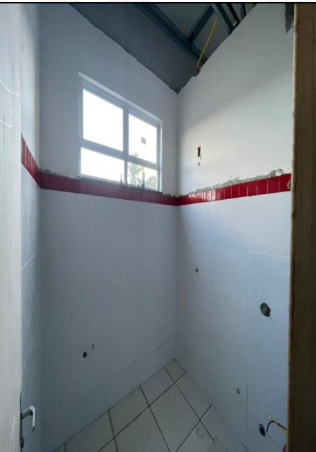
Figura 05: Assentamento do revestimento cerâmico 10x10.
