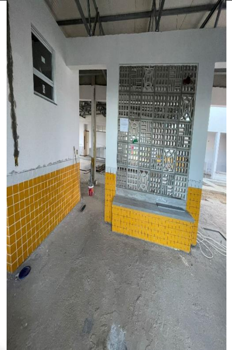
Figura 18: Assentamento do revestimento cerâmico 10x10.
