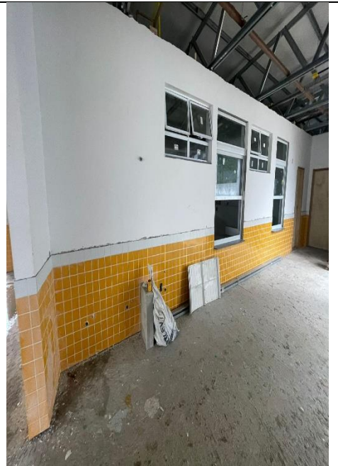
Figura 12: Assentamento de revestimento cerâmico 10x10.
