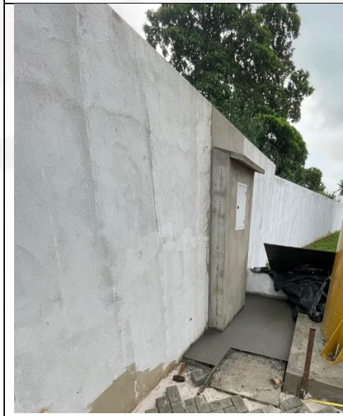
Figura 28: Montagem do QD.
