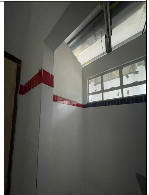
Figura 06: Assentamento do revestimento cerâmico 10x10.
