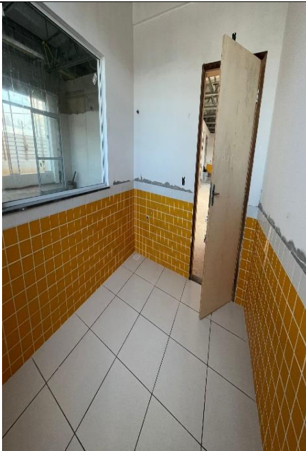
Figura 10: Assentamento de revestimento cerâmico 10x10 e instalação das portas.
