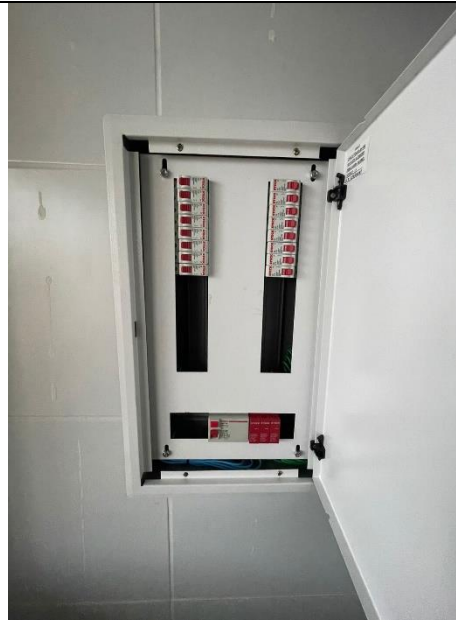
Figura 28: Montagem do QD.
