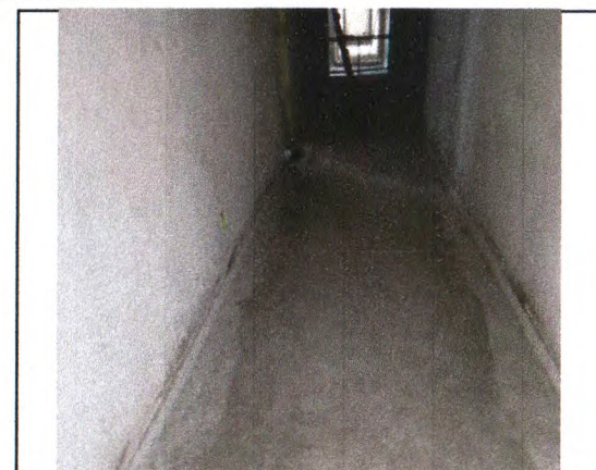
EXECUÇÃO DO PISO DE ALTA RESISTÊNCIA; PAREDES DE ALVENARIA REBOCADAS
