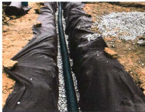
ASSENTAMENTO DA TUBULAÇÃO
