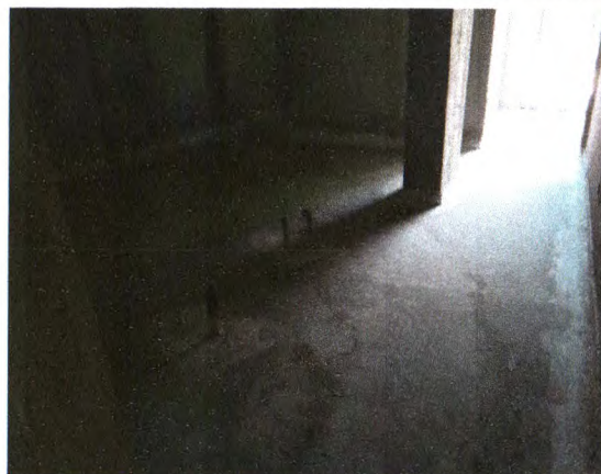
EXECUÇÃO DO PISO DE PISO DE ALTA RESISTÊNCIA
