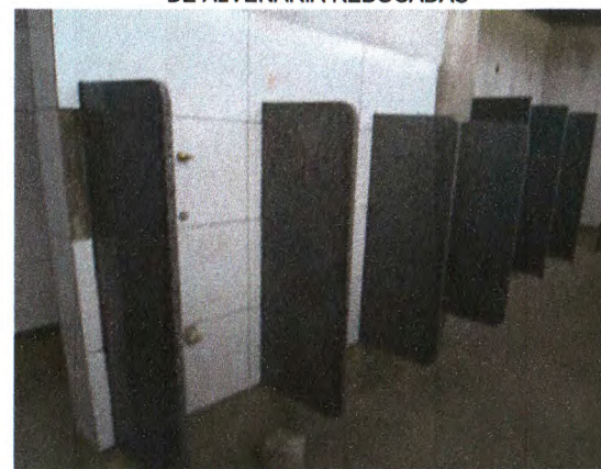
DIVISÓRIAS EM MÁRMORE NOS BANHEIROS
