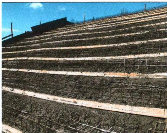
CONCRETAGEM DA LAJE DA ARQUIBANCADA
