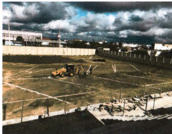
ESCAVAÇÃO PARA REDE DE DRENAGEM
