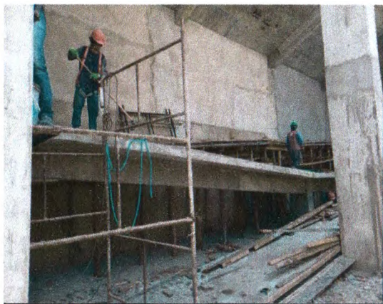
MONTAGEM DAS FORMAS DA RAMPA
