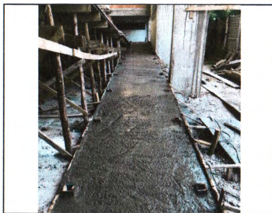
CONCRETAGEM DA RAMPA
