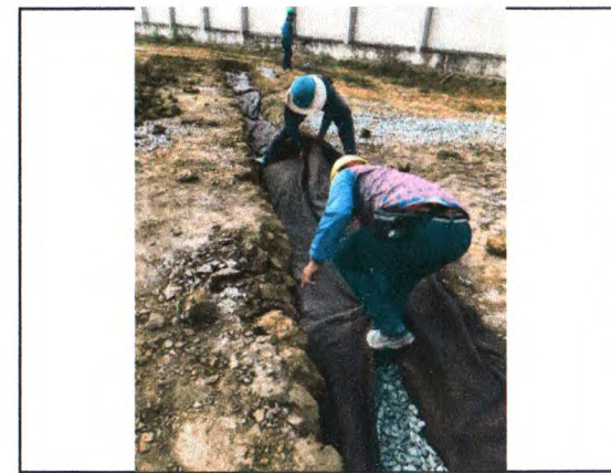
EXECUÇÃO DA REDE DE DRENAGEM
