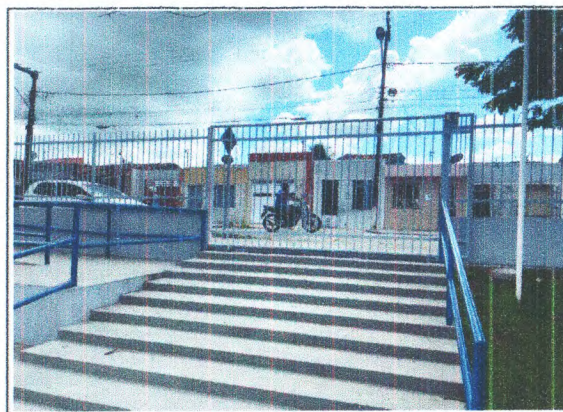
PINTURA RAMPA E ESCADA
