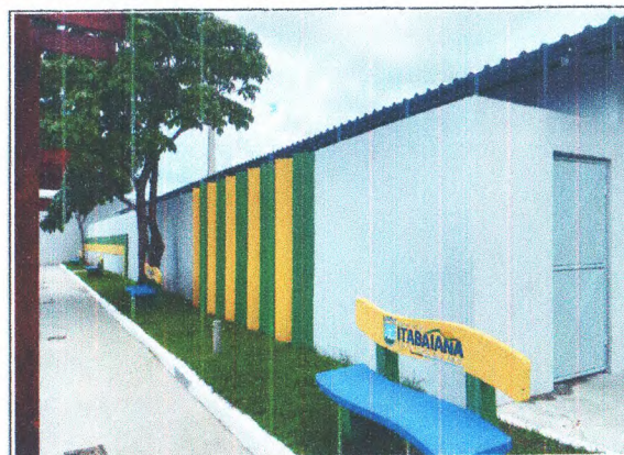
PINTURA DE ACABAMENTO DO MURO
