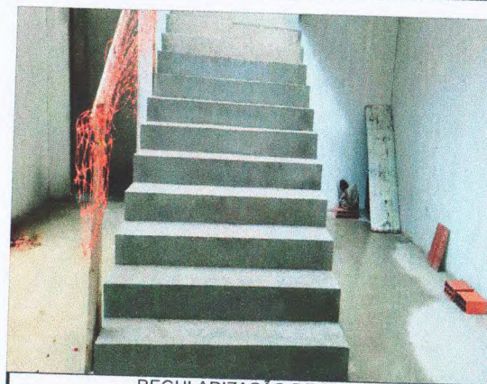
REGULARIZAÇÃO DE PISO
