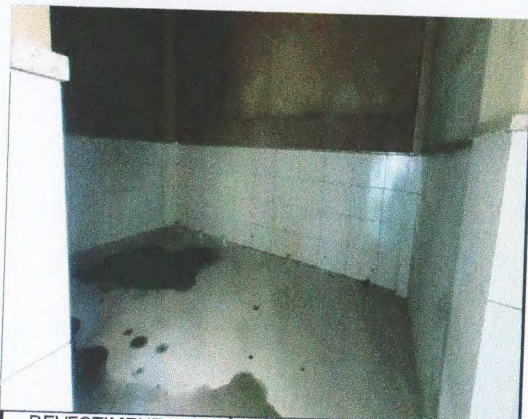
REVESTIMENTO CERÂMICO; FILETE EM GRANITO
