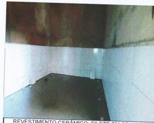
REVESTIMENTO CERÂMICO; FILETE EM GRANITO
