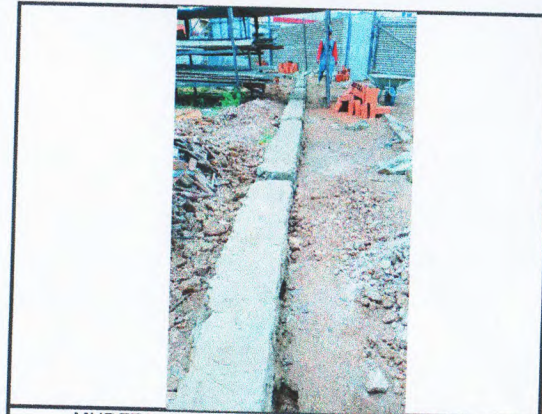
MURETA - BASE EM ALVENARIA DE PEDRA ARGAMASSADA
