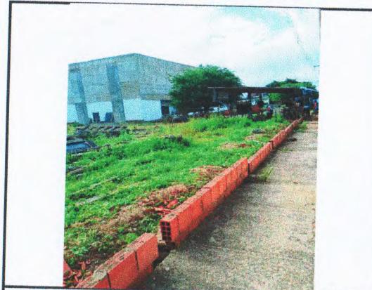
MURETA EM ALVENARIA DE BLOCO CERÂMICO
