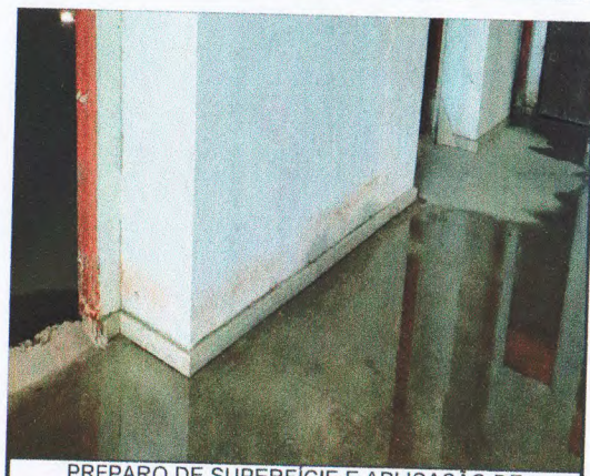
PREPARO DE SUPERFÍCIE E APLICAÇÃO DE SELADOR; RODAPÉ EM GRANITO
