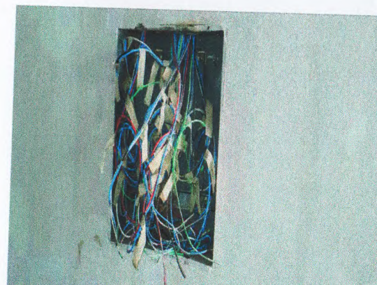
QUADROS DE DISTRIBUIÇÃO; ELETRODUTOS EM PVC
