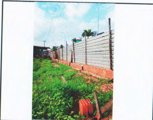
MURETA EM ALVENARIA DE BLOCO CERÂMICO
