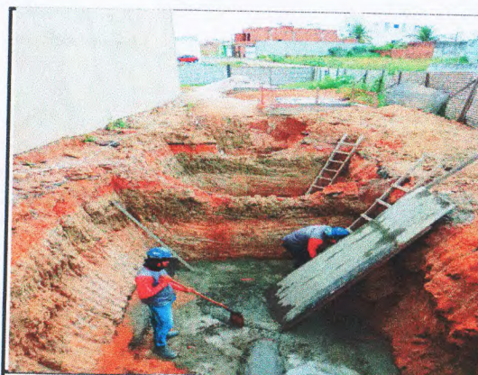
SISTEMA DE TRATAMENTO DE ESGOTO - ESCAVAÇÃO/REGULARIZAÇÃO
