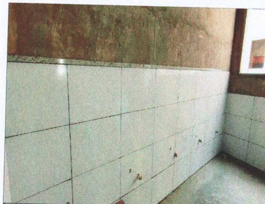
REVESTIMENTO CERÂMICO; FILETE EM GRANITO
