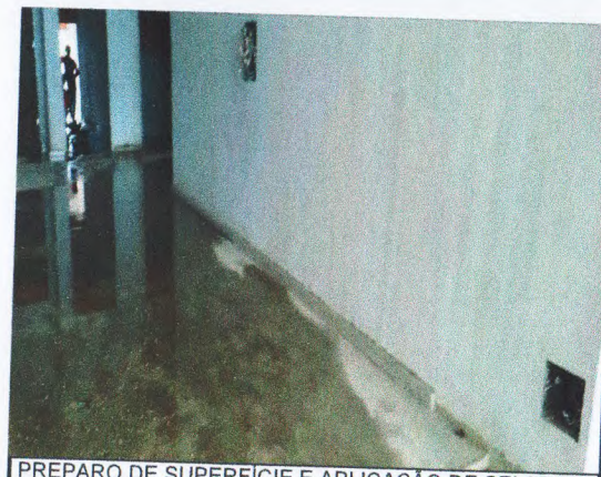
PREPARO DE SUPERFÍCIE E APLICAÇÃO DE SELADOR; RODAPÉ EM GRANITO
