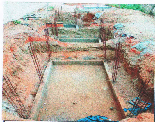
SISTEMA DE TRATAMENTO DE ESGOTO - FUNDAÇÃO/ESTRUTURA
