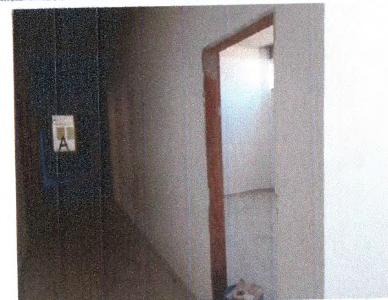
PINTURA INTERNA; CAIXÃO DE PORTA EM MADEIRA
