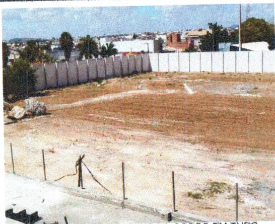
PINTURA DO MURO; GUARDA-CORPO EM TUBO GALVANIZADO
