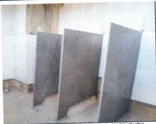
INSTALAÇÃO DE DIVISÓRIAS; REVESTIMENTO CERÂMICO
