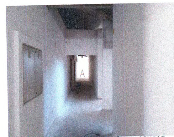
PINTURA INTERNA; INSTALAÇÕES ELÉTRICAS
