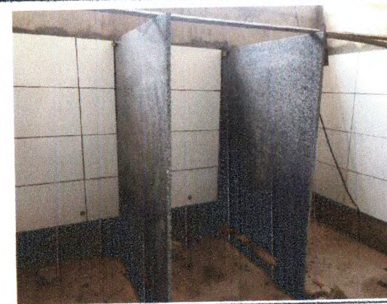
INSTALAÇÃO DE DIVISÓRIAS; REVESTIMENTO CERÂMICO
