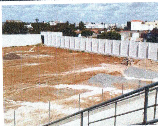
PINTURA DO MURO; GUARDA-CORPO EM TUBO GALVANIZADO
