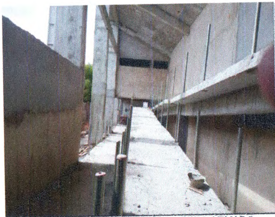
RAMPAS DE ACESSO EM CONCRETO ARMADO; GUARDA-CORPO EM TUBO GALVANIZADO
