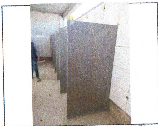
INSTALAÇÃO DE DIVISÓRIAS; REVESTIMENTO CERÂMICO
