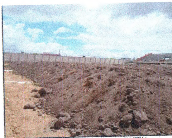
ESPALHAMENTO DE TERRA VEGETAL
