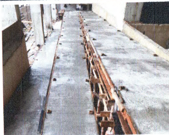
CONCRETAGEM DA RAMPA
