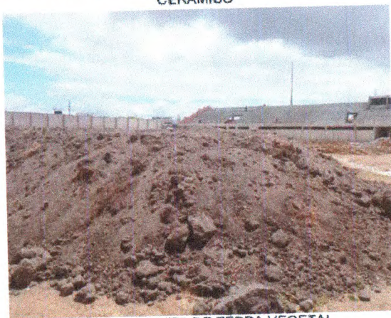
ESPALHAMENTO DE TERRA VEGETAL
