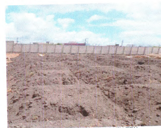
ESPALHAMENTO DE TERRA VEGETAL
