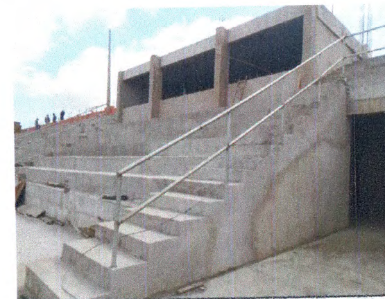
EXECUÇÃO DE PISO EM ALTA RESISTÊNCIA; GUARDA- CORPO EM TUBO GALVANIZADO; ALVENARIA DE BLOCO CERÂMICO
