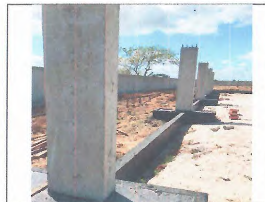
QUADRA - IMPERMEABILIZAÇÃO DA FUNDAÇÃO; CONCRETO ARMADO DOS PILARES
