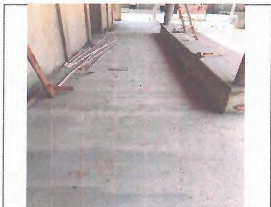
CONTRAPISO E PISO EM ALTA RESISTÊNCIA
