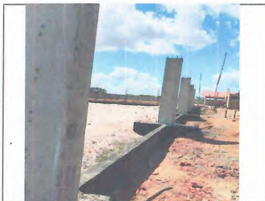
QUADRA - IMPERMEABILIZAÇÃO DA FUNDAÇÃO; CONCRETO ARMADO DOS PILARES
