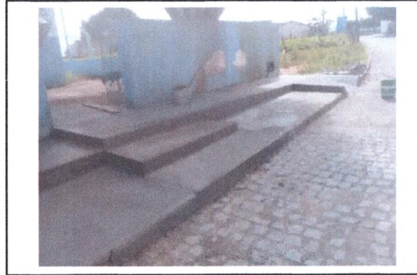
PISO EM CONCRETO SIMPLES
