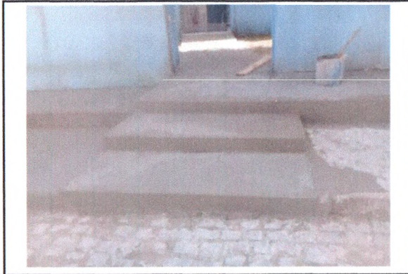
PISO EM CONCRETO SIMPLES
