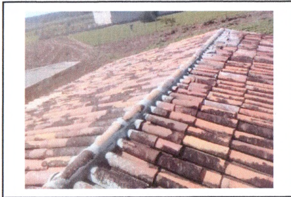
REVISÃO DE COBERTURA COM TELHA CERÂMICA EMASSAMENTO DE ALGEROZ
