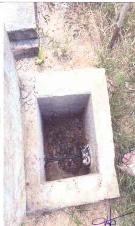
Figura 11: Execução de acabamento das caixas de inspeção.
