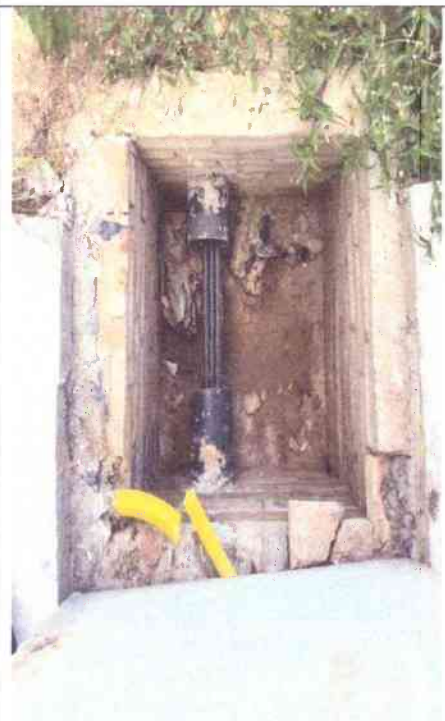
Figura 10: Execução de caixas de inspeção em alvenaria.
