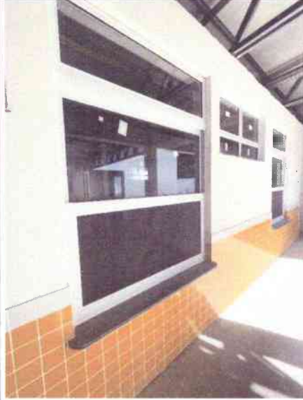
Figura 02: Fixação da tela mosquiteiro nas esquadrias.
