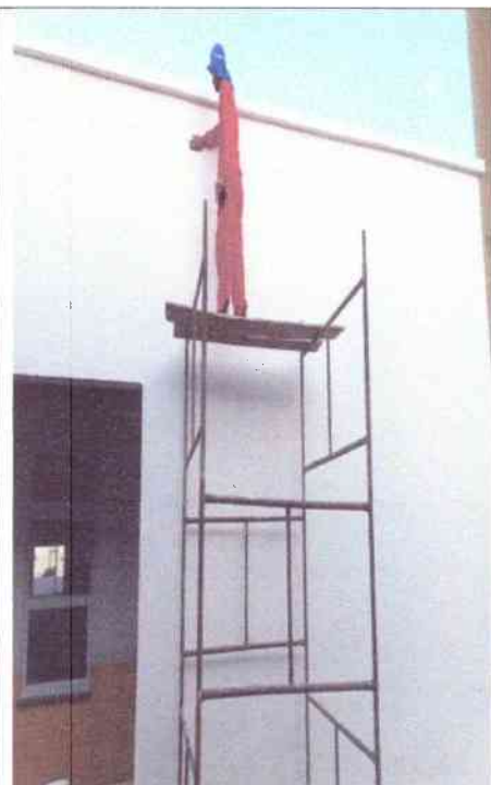
Figura 12: Lixamento e emassamento de paredes externas.
