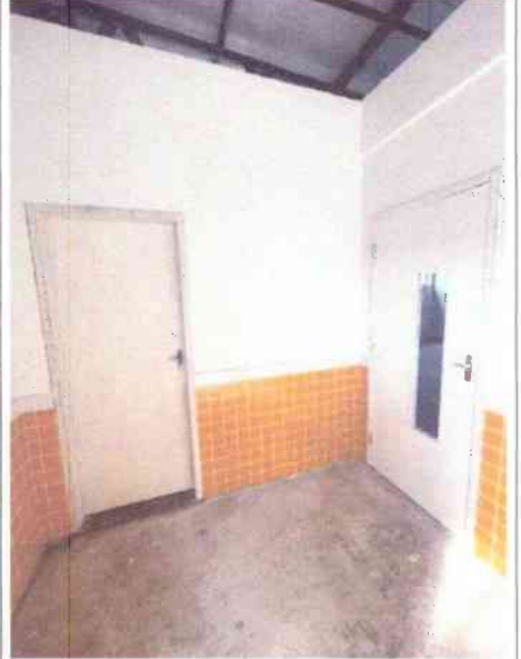
Figura 03: Aplicação de fundo nivelador e emassamento nas portas.
