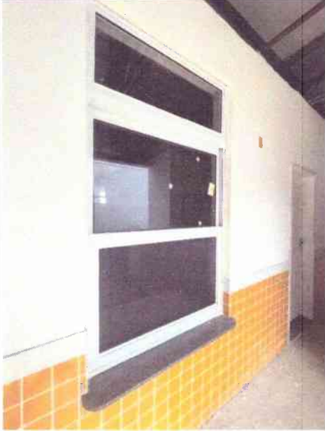
Figura 01: Fixação da tela mosquiteiro nas esquadrias.
