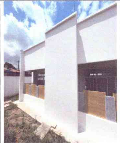
Figura 18: Emassamento de paredes externas.
