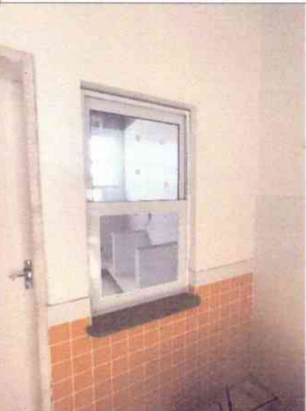
Figura 05: Fixação da tela mosquiteiro nas esquadrias.
