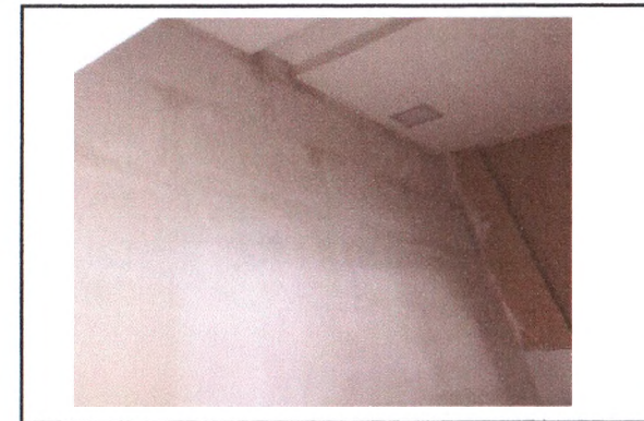
PAREDE EM BLOCO DE GESSO
