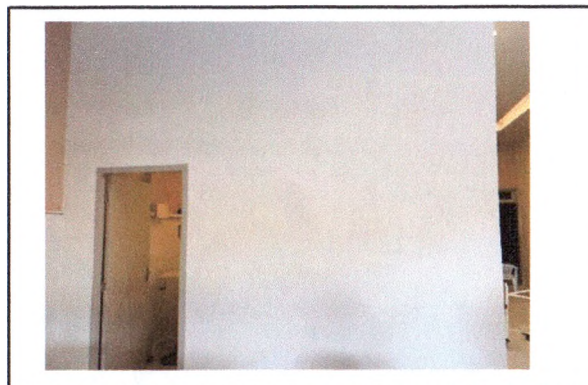
PINTURA DE ACABAMENTO COM TINTA ACRÍLICA E PINTURA DE ACABAMENTO COM ESMALTE SINTÉTICO
