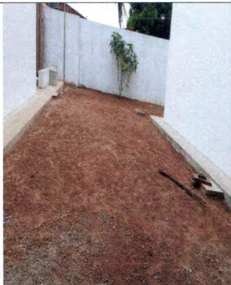
Figura 01: aterro e nivelamento do terreno
