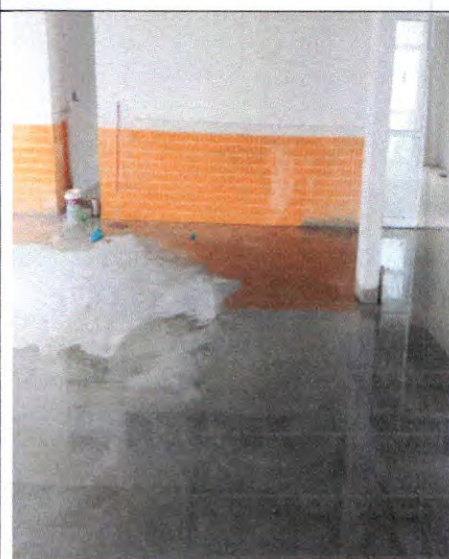
Figura 06: Execução do piso polido.
