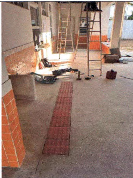
Figura 02: Instalação do piso tátil.
