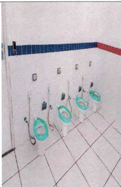
Figura 11: fixação de louças e acessórios.
