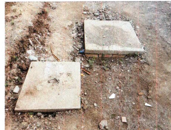
CAIXAS DE PASSAGEM EM ALVENARIA DE TIJOLO MACIÇO E CONCRETO ARMADO
