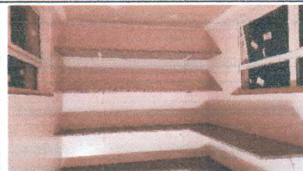
Figura 06: Instalação de prateleiras em granito com mão francesa.
