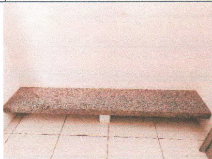
Figura 05: Instalação de bancada em granito
