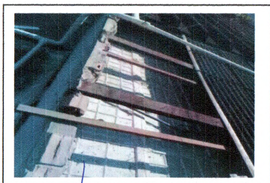
DEMOLIÇÃO DE REBOCO, ALVENARIA DE BLOCO CERÂMICO, NOVO REBOCO (FARMÁCIA)
