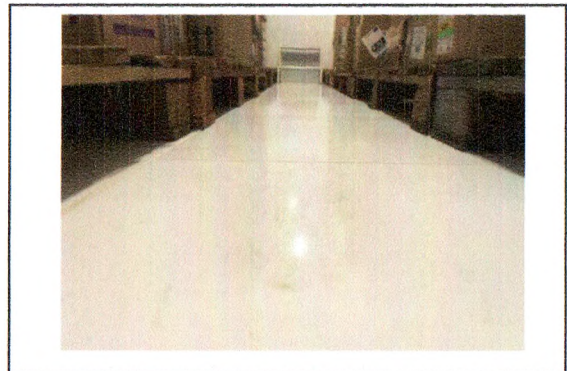
REVESTIMENTO CERÂMICO PISO (FARMÁCIA)
