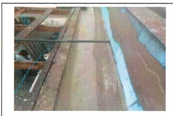
IMPERMEABILIZAÇÃO COM MANTA ASFÁLTICA (FARMÁCIA)
