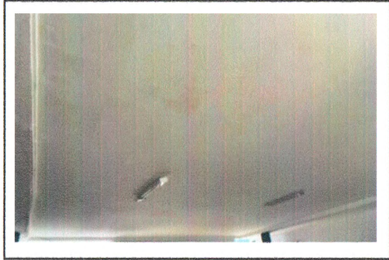
FORRO DE GESSO (RECEPÇÃO)
