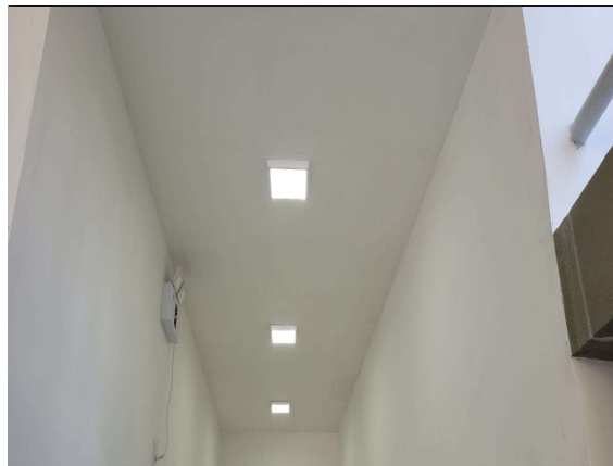
LUMINÁRIAS; PINTURA INTERNA TETO E PAREDES
