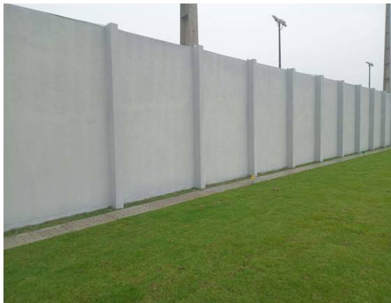
PLANTIO DA GRAMA ESMERALDA; PINTURA DO MURO
