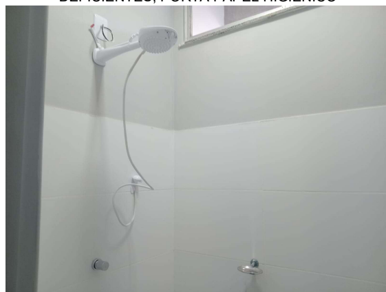
CHUVEIRO ELÉTRICO; PORTA SABÃO; PINTURA INTERNA PAREDE
