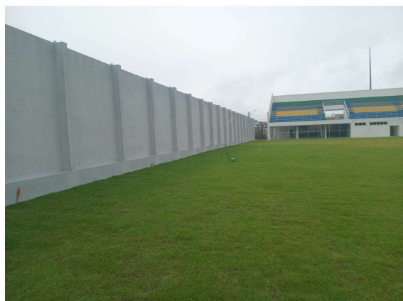
PLANTIO DA GRAMA ESMERALDA; PINTURA DO MURO
