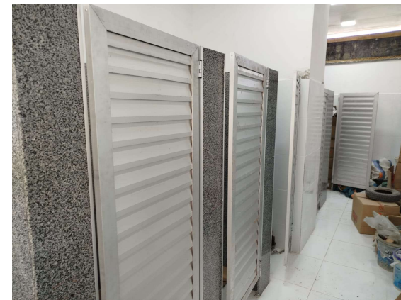
PORTAS EM ALUMÍNIO; PINTURA INTERNA PAREDES
