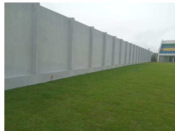
PLANTIO DA GRAMA ESMERALDA; PINTURA DO MURO
