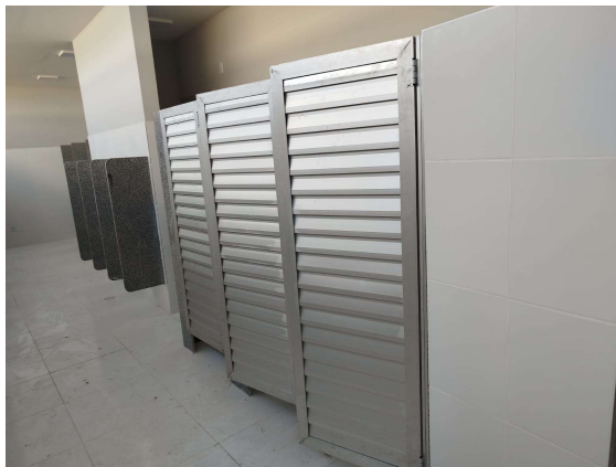
PORTAS EM ALUMÍNIO; PINTURA INTERNA TETO E PAREDES
