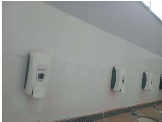
PORTA SABÃO LÍQUIDO; PINTURA INTERNA PAREDE
