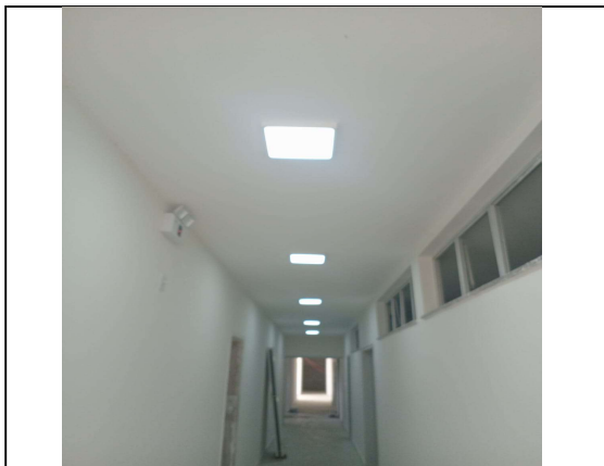
LUMINÁRIAS; PINTURA INTERNA TETO E PAREDES
