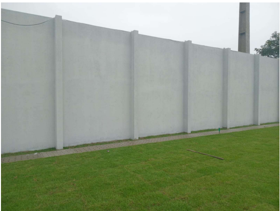
PLANTIO DA GRAMA ESMERALDA; PINTURA DO MURO
