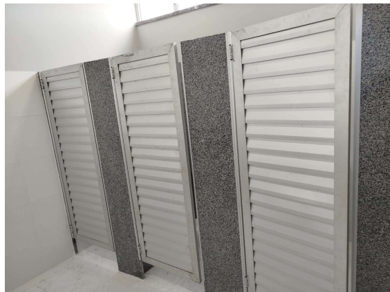
PORTAS EM ALUMÍNIO; PINTURA INTERNA PAREDES
