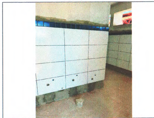
REVESTIMENTO CERÂMICO PAREDES; PINTURA PAREDES
