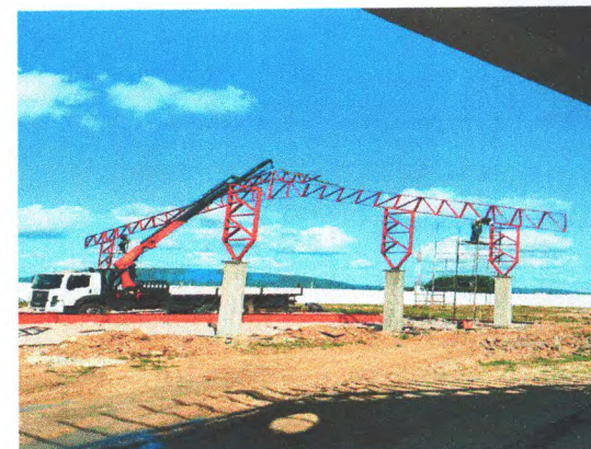
QUADRA DE ESPORTES - ESTRUTURA METÁLICA
