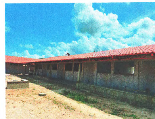
TELHAMENTO E CUMEEIRA CERÂMICA; ESTRUTURA METÁLICA; PINTURA PAREDES
