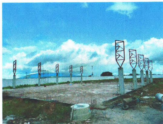
QUADRA DE ESPORTES - ESTRUTURA METÁLICA
