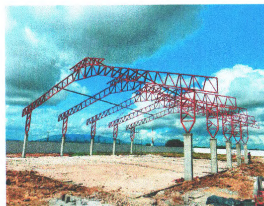
QUADRA DE ESPORTES - ESTRUTURA METÁLICA
