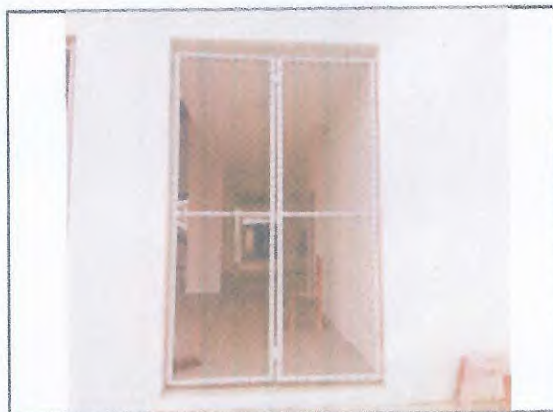
PORTÃO EM ALAMBRADO DE TUBO E TELA GALVANIZADA; PINTURA EXTERNA
