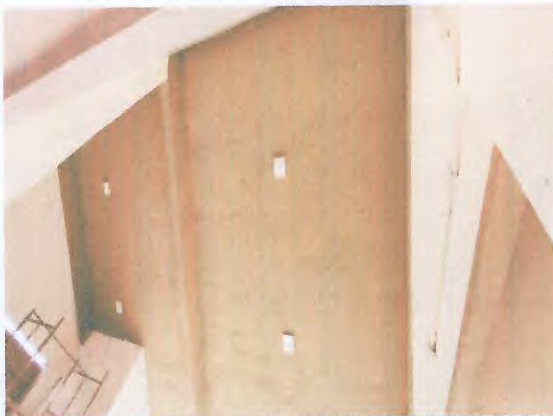
PINTURA INTERNA TETO E PAREDES
