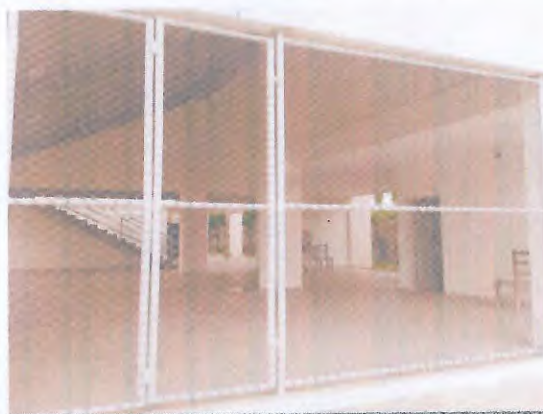
PORTÃO EM ALAMBRADO DE TUBO E TELA GALVANIZADA
