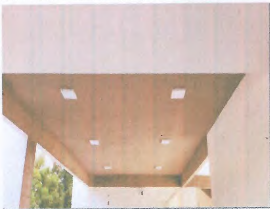
PINTURA INTERNA TETO E PAREDES
