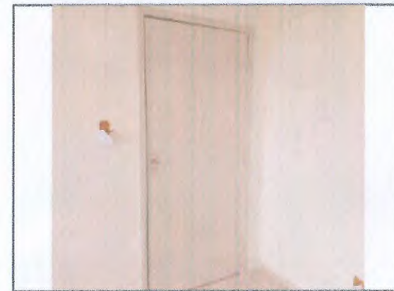
PORTA EM DRYWALL; PINTURA - PAREDES E PORTA
