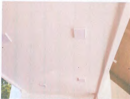
PINTURA INTERNA TETO E PAREDES
