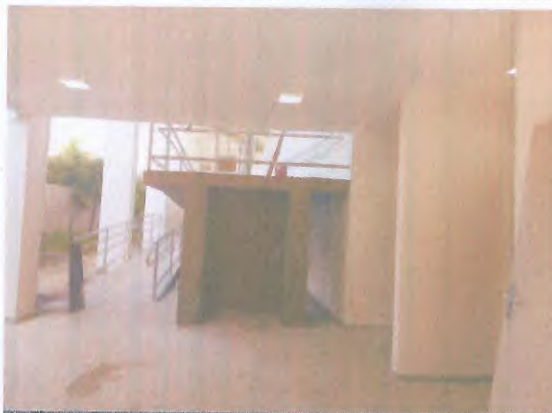
PINTURA INTERNA TETO E PAREDES
