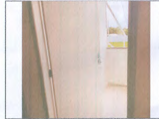
PORTA EM DRYWALL; PINTURA - PAREDES E PORTA
