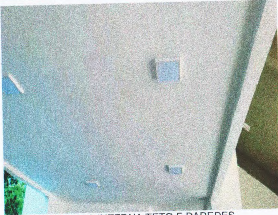
PINTURA INTERNA TETO E PAREDES
