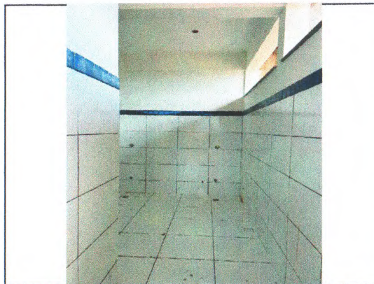
PINTURA PAREDES; REVESTIMENTO CERÂMICO PISO E PAREDES; PINTURA PAREDES
