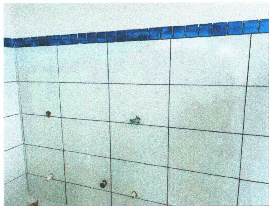
PINTURA PAREDES; REVESTIMENTO CERÂMICO PAREDES; PINTURA PAREDES
