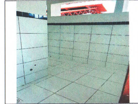
PINTURA PAREDES; REVESTIMENTO CERÂMICO PISO E PAREDES; PINTURA PAREDES
