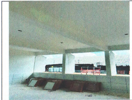
REVESTIMENTO CERÂMICO PAREDES; PINTURA PAREDES E TETO
