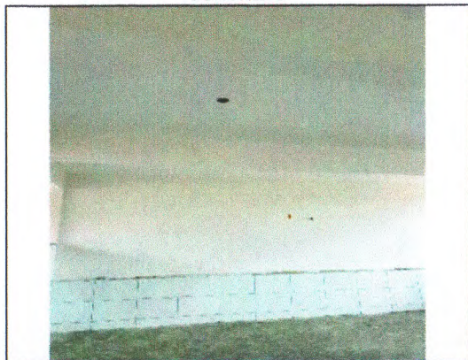
REVESTIMENTO CERÂMICO PAREDES; PINTURA PAREDES E TETO
