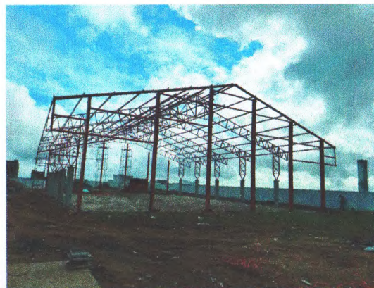
QUADRA DE ESPORTES - ESTRUTURA METÁLICA
