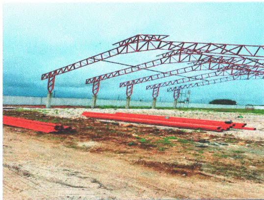
QUADRA DE ESPORTES - ESTRUTURA METÁLICA
