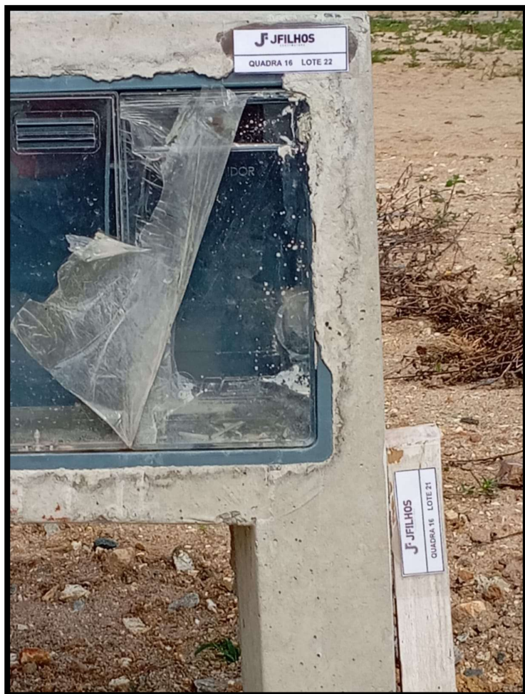
Foto 7 - Demarcação de lotes na quadra 16 lote 22 e 21
