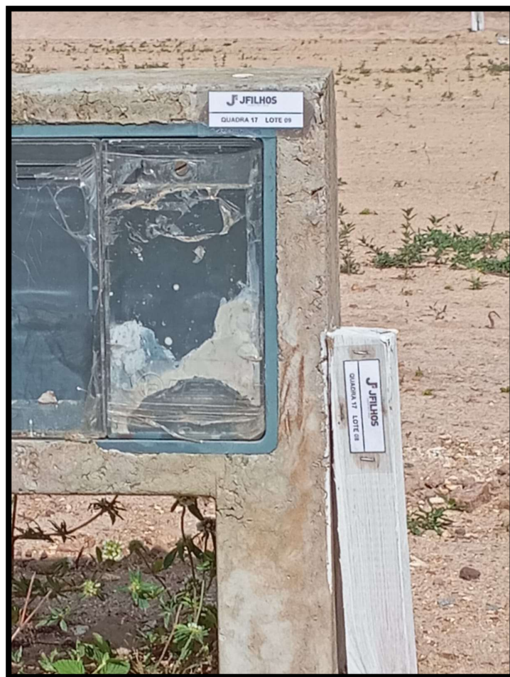
Foto 4 - Demarcação de lotes na quadra 17 lote 09 e 08
