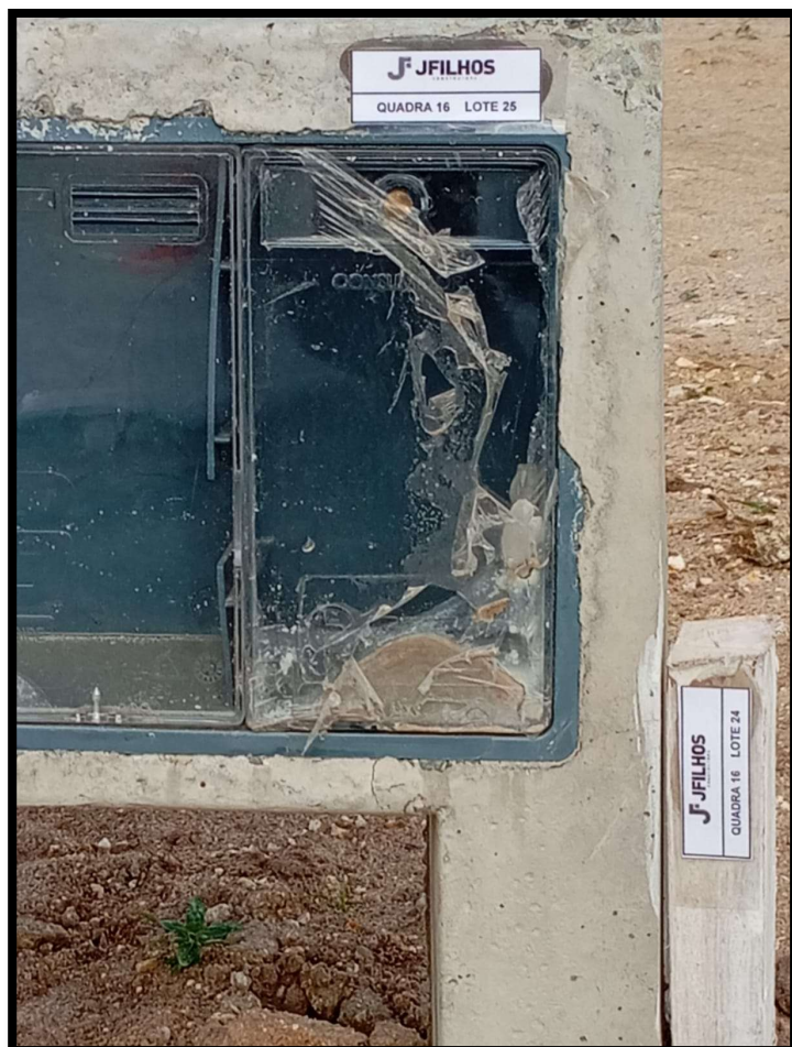
Foto 5 - Demarcação de lotes na quadra 16 lote 25 e 24
