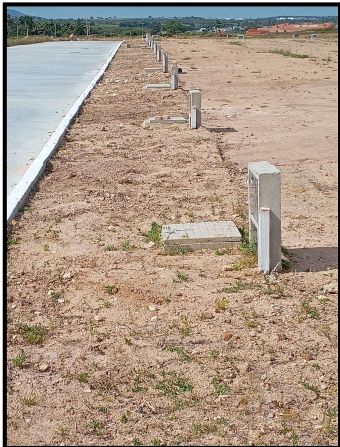
Foto 1 - Demarcação de Lotes na Quadra 17
