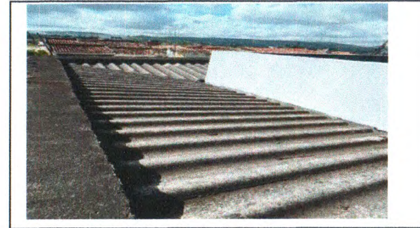
INSTALAÇÃO DE CALHAS E IMPERMEABILIZAÇÃO
