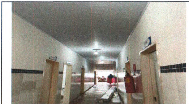
INSTALAÇÃO DE FORRO DE PVC
