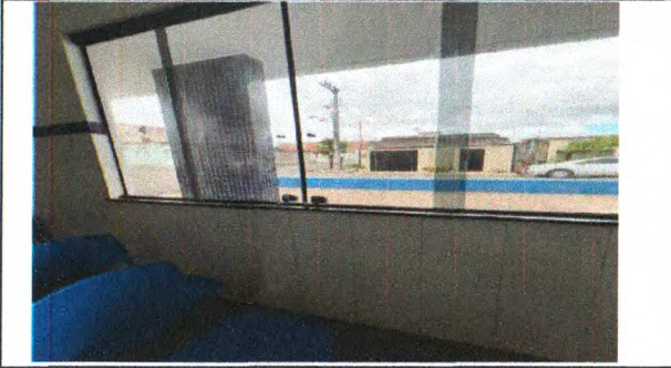
INSTALAÇÃO DE VIDRO LISO INCOLOR
