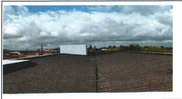
MANUTENÇÃO (REMOÇÃO E TELHAMENTO), INSTALAÇÃO DE CALHAS E IMPERMEABILIZAÇÃO
