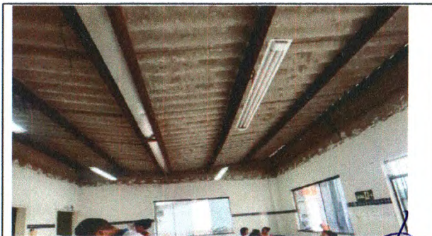
DEMOLIÇÃO DE FORRO DE GESSO E TROCA DE MADEIRAMENTO DO TELHADO
