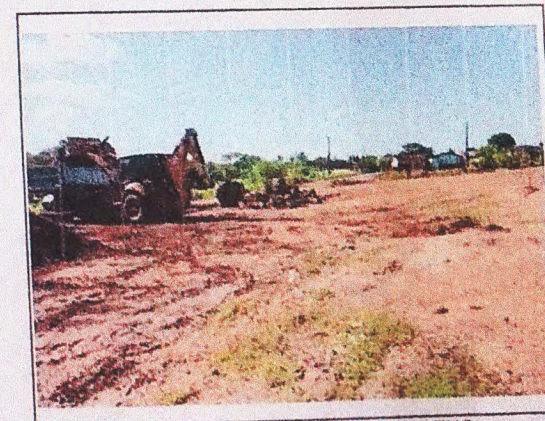
LIMPEZA MECANIZADA DE TERRENO
