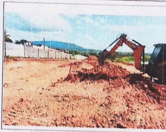
LIMPEZA MECANIZADA DE TERRENO
