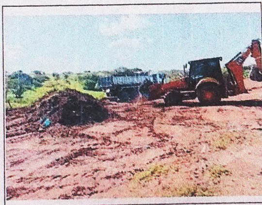
LIMPEZA MECANIZADA DE TERRENO
