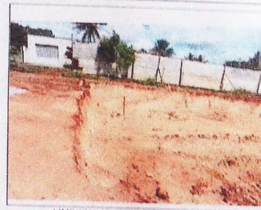
LIMPEZA MECANIZADA DE TERRENO
