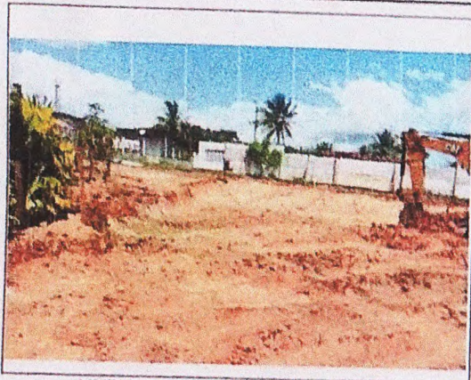
LIMPEZA MECANIZADA DE TERRENO
