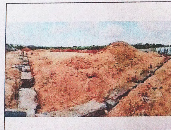
IMPLANTAÇÃO DE SAPATAS E ALVENARIA DE PEDRA QUADRA
