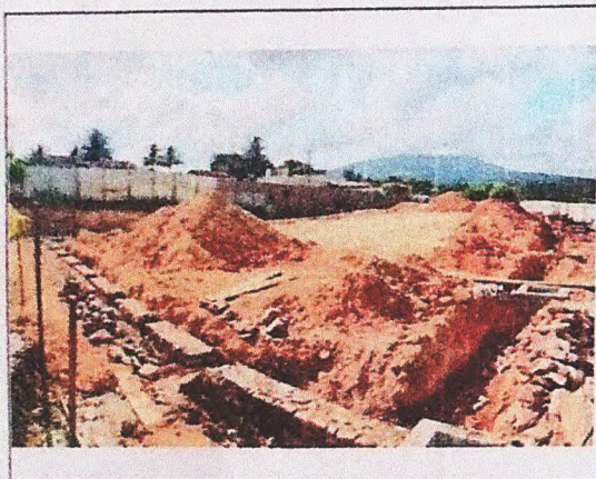
IMPLANTAÇÃO DE SAPATAS E ALVENARIA DE PEDRA QUADRA
