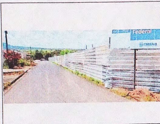
TAPUME EM CHAPA METÁLICA
