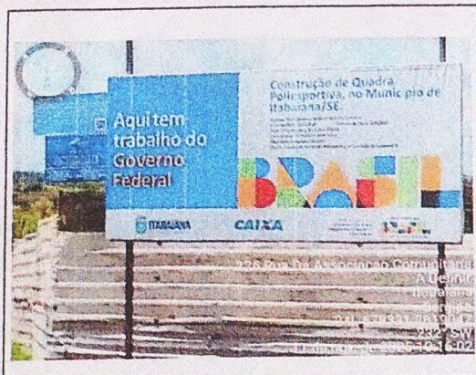
INSTALAÇÃO DE PLACA DE OBRA
