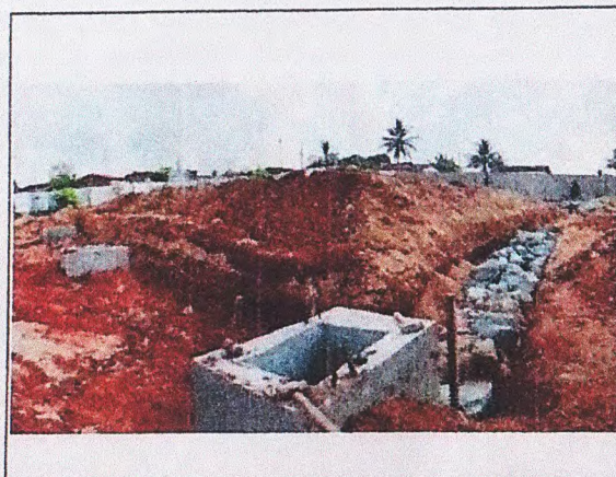
IMPLANTAÇÃO DE SAPATAS E ALVENARIA DE PEDRA QUADRA
