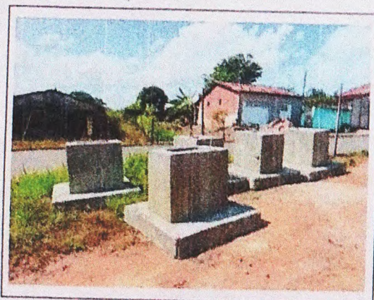
SAPATAS GALPÃO PRÉ-MOLDADO
